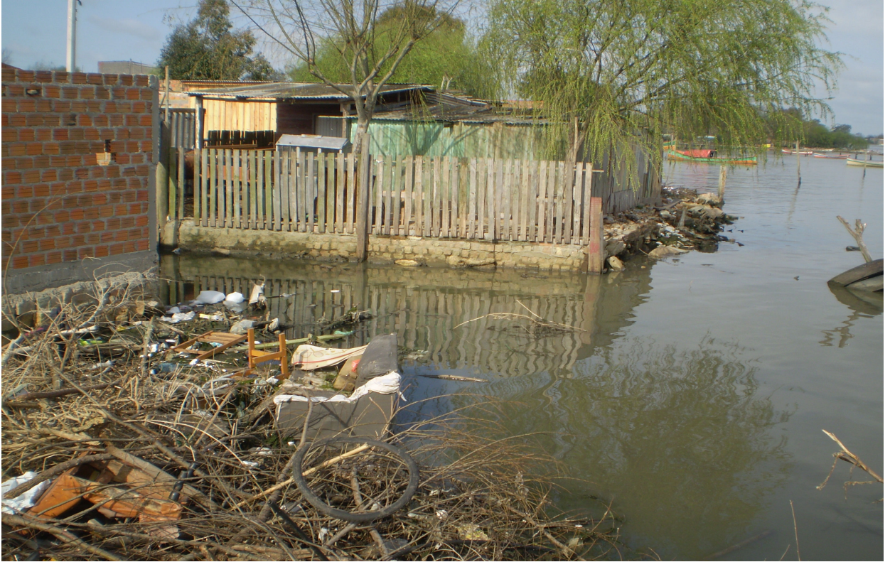
Figura D.8 - Aterramento das margens do Saco da Mangueira Fonte: Elaboração própria
