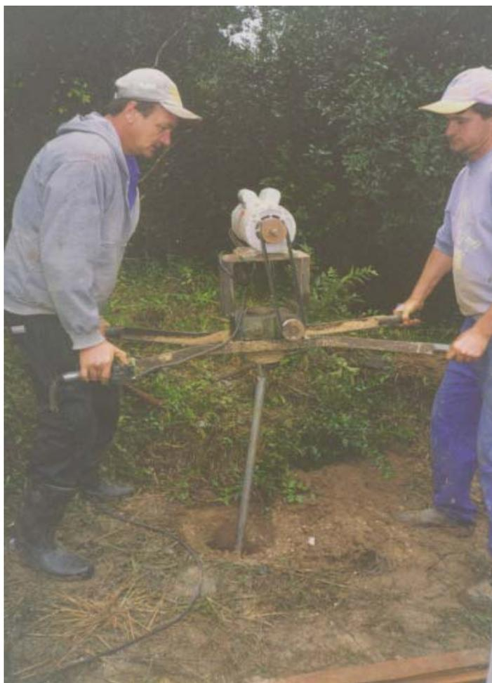
Figura 18: Perfuração para instalação do poço, através de trado manual
