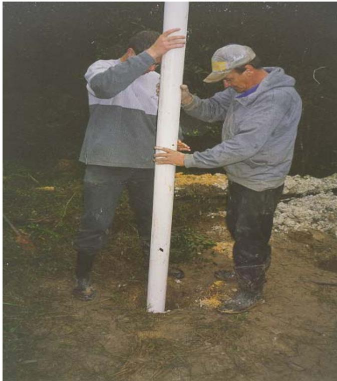
Figura 19: Colocação de filtro (tubo de PVC ranhurado em sua parte inferior)
