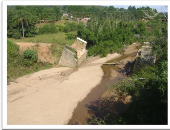
Foto 4 – Ponte destruída pelo forte volume de água no arroio do Ouro, afluente da BHAP em janeiro de 2009. Na foto observa-se a quantidade de sedimentos que foram transportados para o leito do arroio. Autora: Érica I. Megiato (2009).
