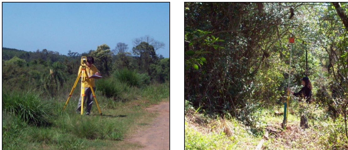
Figura 23 - Foto da realização do levantamento planialtimétrico dos piezômetros instalados na área da UTRESA.
