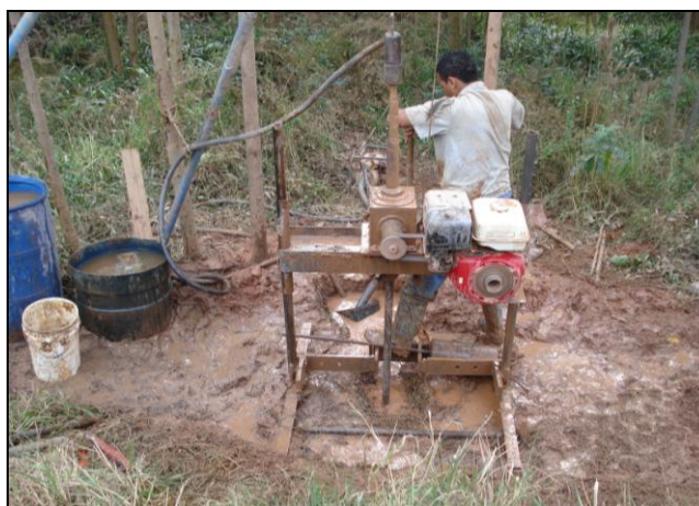
Figura 12 - Foto da sonda rotativa utilizada para a perfuração, amostragem do ponto PZ 26.
