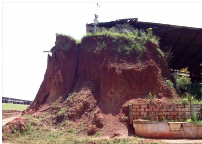
Figura 26 - Foto do corte próximo à Célula X, evidenciando os horizontes B e C do solo residual da Fm. Sanga do Cabral, com mais de 3 m de espessura.
