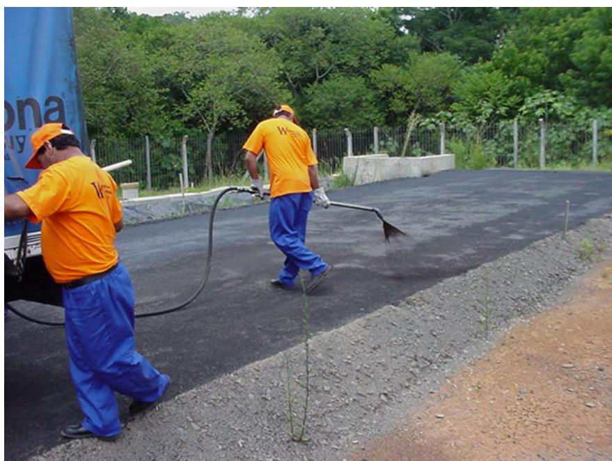
Figura 3.19: Aplicação da pintura de ligação nas pistas desta pesquisa
