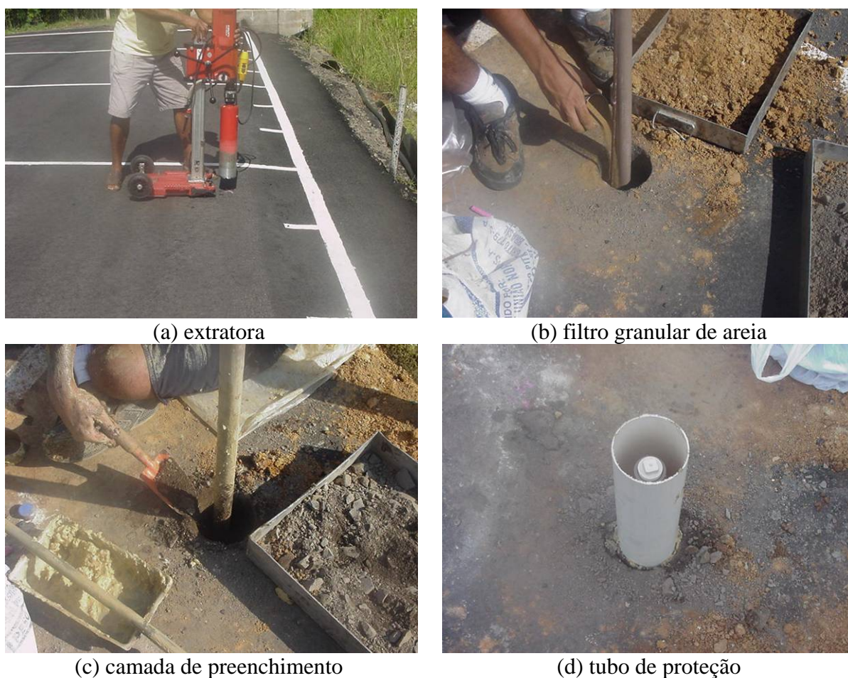
Figura 3.38: Sequência para instalação dos piezômetros nas pistas experimentais
