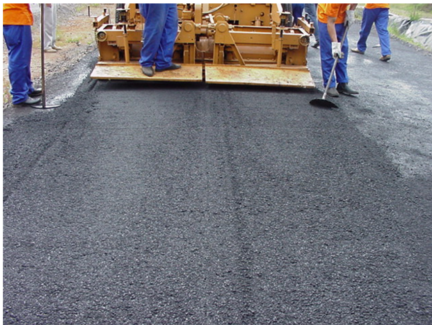
Figura 3.20: Espalhamento do concreto asfáltico nas pistas desta pesquisa
