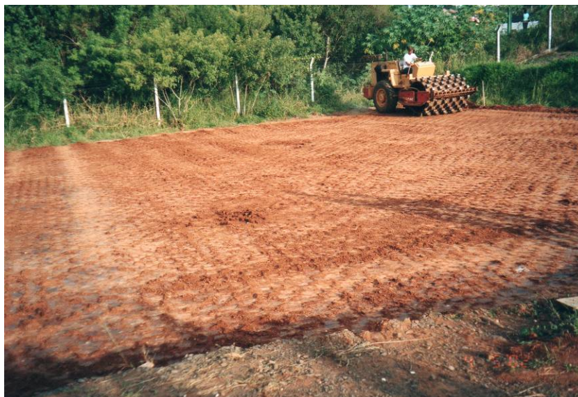
Figura 3.15: Execução da camada final de terraplenagem
