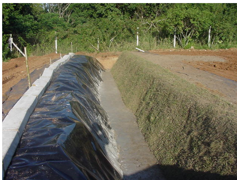
Figura 3.30: Execução do dreno a céu aberto na Pista B desta pesquisa
