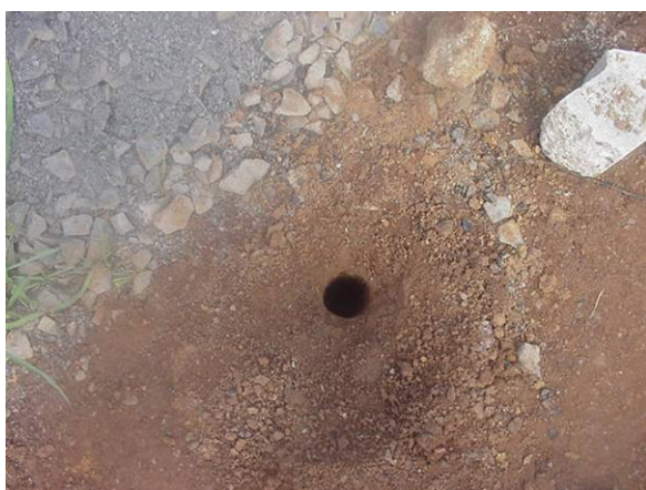
(a) furo escavado
