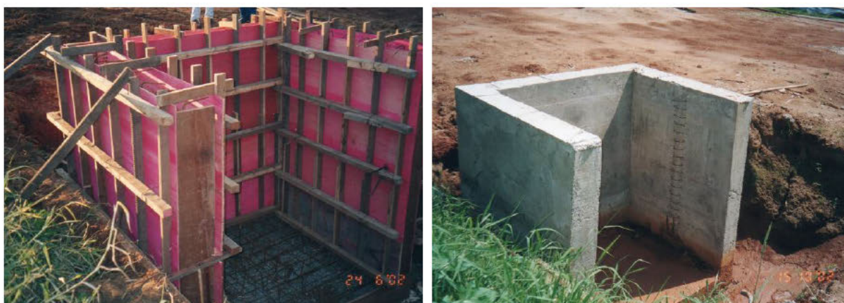
Figura 3.31: Execução do dispositivo na saída do dreno DPS 05 na Pista A desta pesquisa
