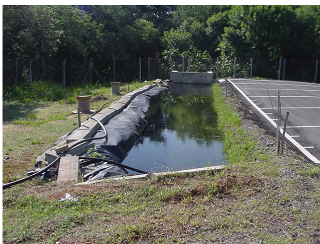
Figura 6.11: Aplicação do estágio 7 (cota 0,0 m) no dreno a céu aberto
