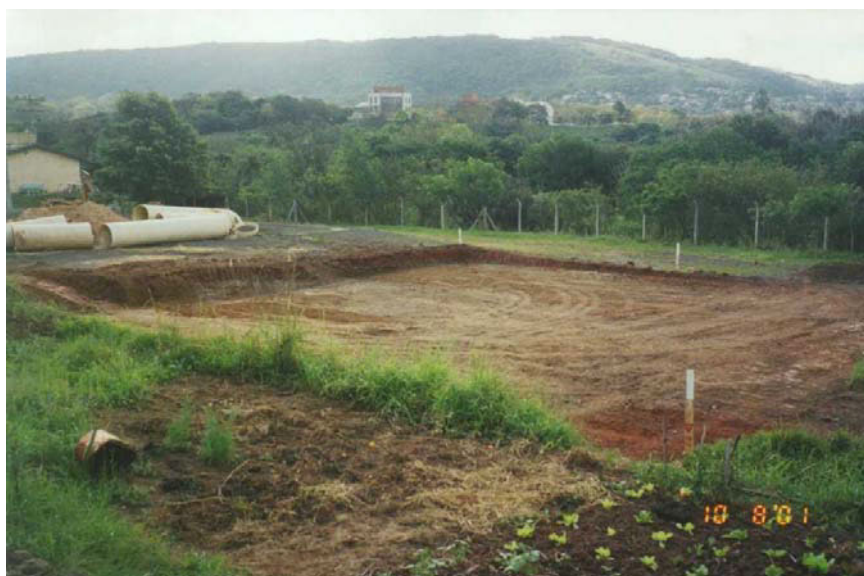
Figura 3.14: Terraplenagem na área das pistas experimentais
