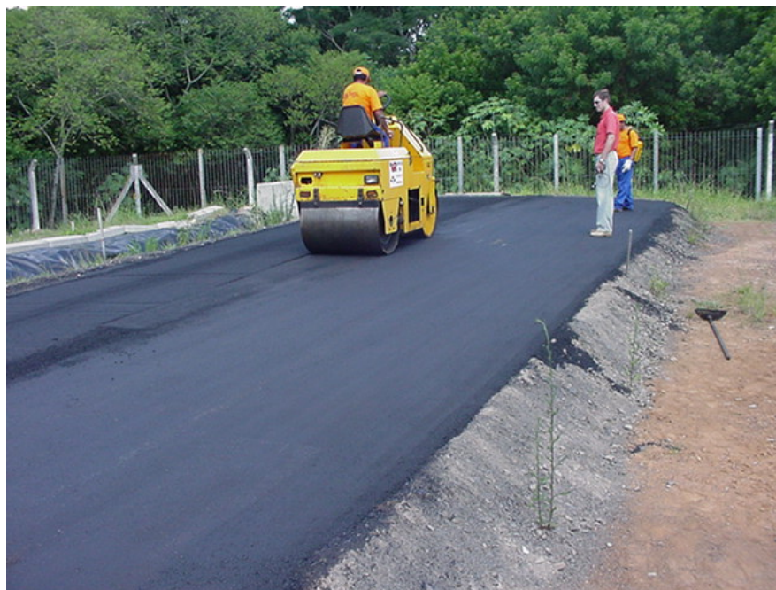
Figura 3.22: Compactação com rolo liso nas pistas desta pesquisa
