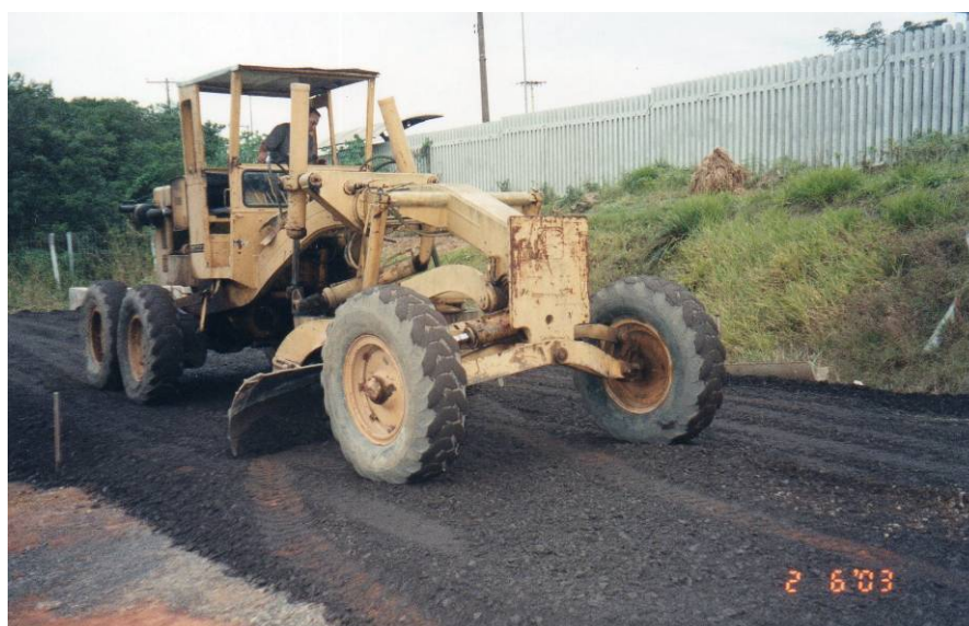
Figura 3.16: Distribuição da brita graduada
