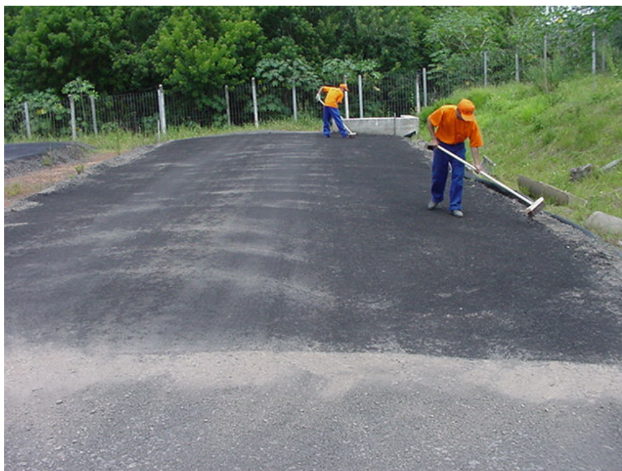
Figura 3.18: Limpeza da superfície da camada de base desta pesquisa
