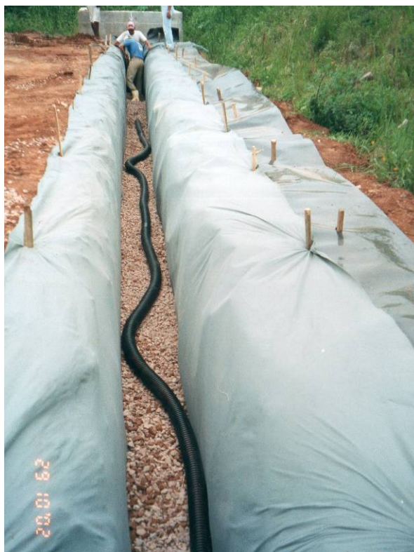
Figura 3.29: Execução do dreno DPS 05 na Pista A desta pesquisa
