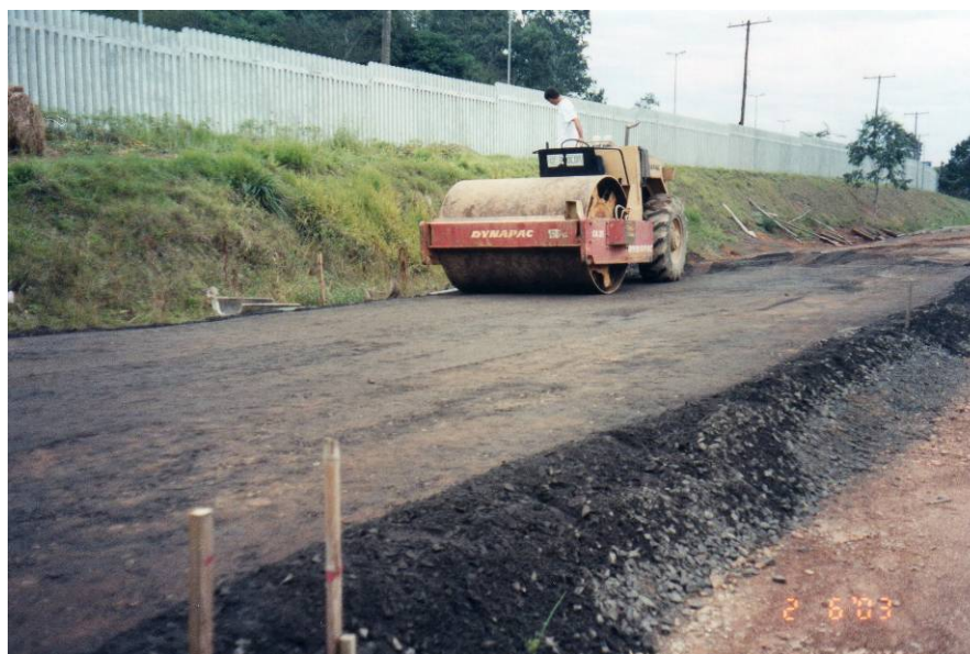
Figura 3.17: Compactação da camada de base
