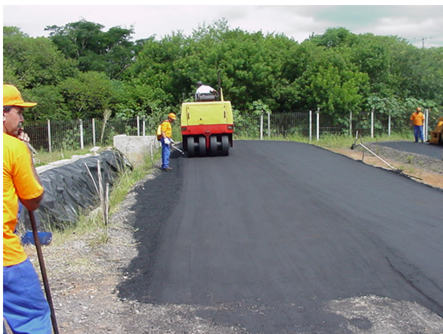
Figura 3.21: Compactação com rolo pneumático nas pistas desta pesquisa
