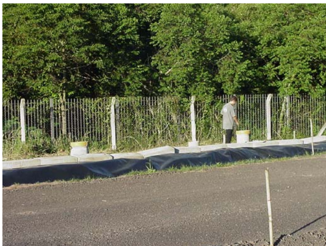
Figura 6.3: Ilustração da coleta de leitura de campo para monitoramento da profundidade do lençol freático nas pistas experimentais desta pesquisa
