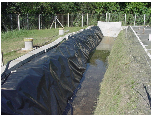
Figura 6.10: Alterando do estágio 2 para o estágio 3 no dreno a céu aberto
