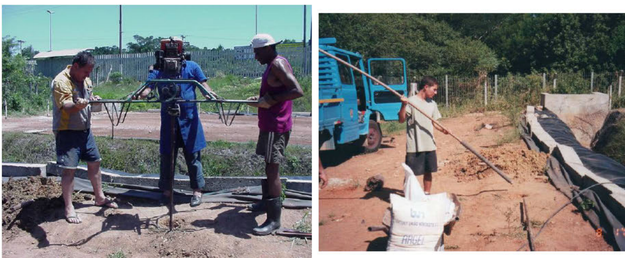
Figura 3.34: Instalação do piezômetro P1 no local desta pesquisa
