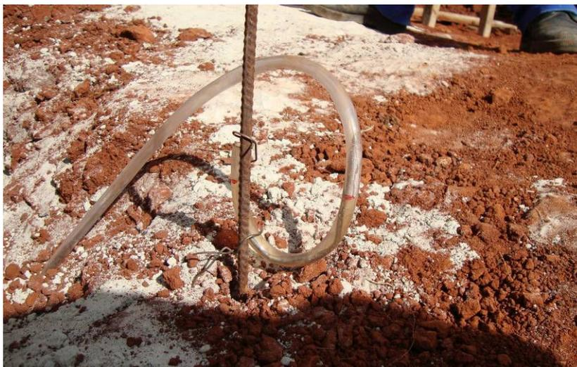
Figura 4.20: Vaso comunicante em “U” executado junto à extremidade da mangueira de ventilação que sobrava na superfície
