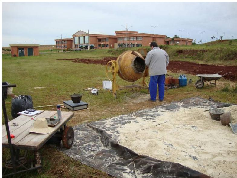
Figura 4.7: Vista do aparato utilizado para a execução do reaterro (betoneira, duas balanças, dois carrinhos, baldes metálicos, fogareiro e botijão de gás liquefeito de petróleo – GLP, etc.), depósito de areia e reservatório de água
