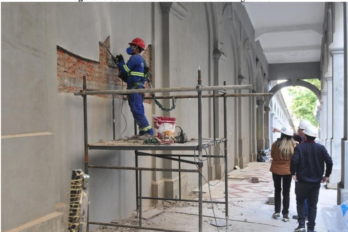
Figura 2: Obra do Viaduto Otávio Rocha em agosto/2024
