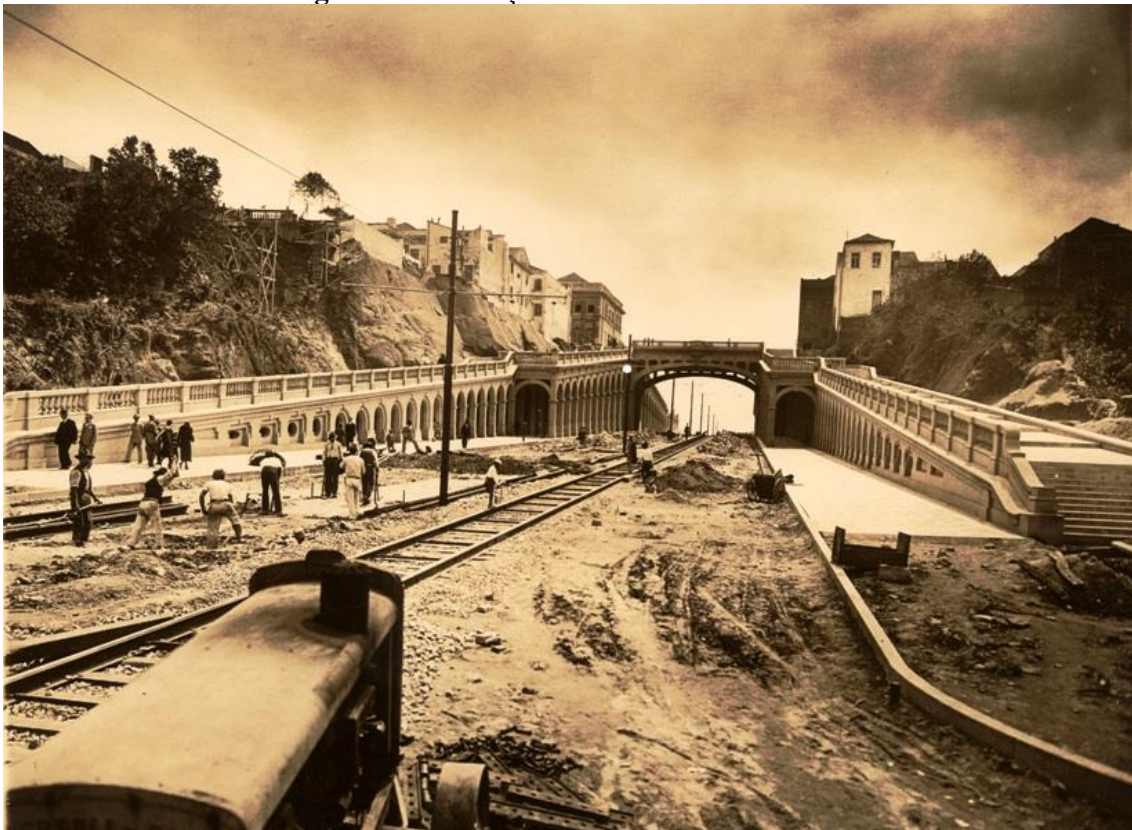
Figura 1: Construção do Viaduto Otávio Rocha
