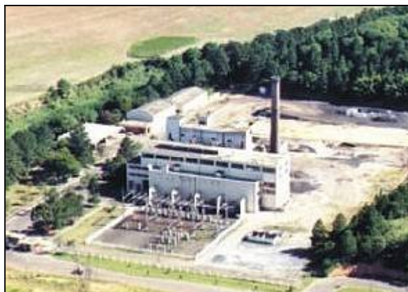
Figura 6. Usina termelétrica de Figueira, Paraná.
