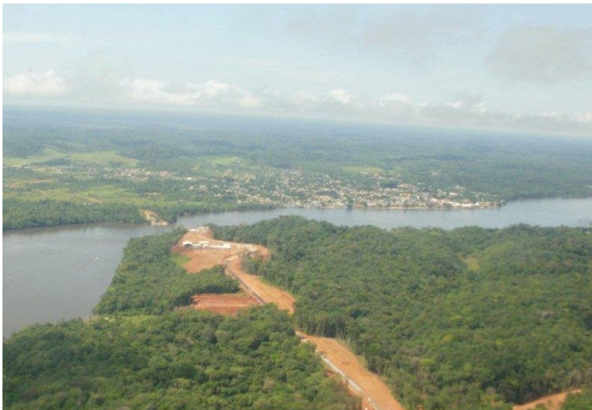
Ilustração 10 – Construção da ponte internacional entre Brasil e Guiana Francesa. Fonte: GRANGER, STEPHANE. JUL, 2010.
