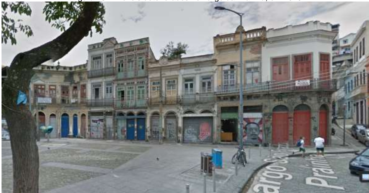
Figura 78 - Imóveis deteriorados no Largo da Prainha, em 2016
