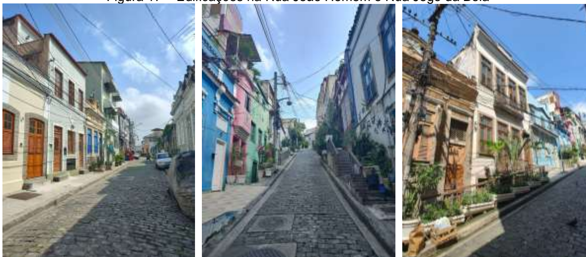
Figura 17 – Edificações na Rua João Homem e Rua Jogo da Bola
