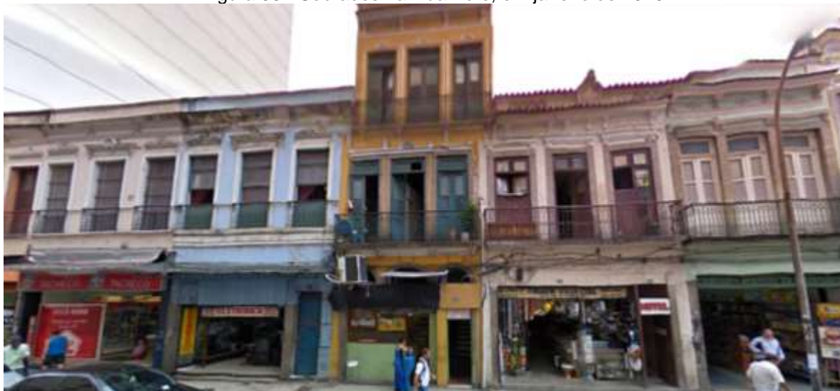
Figura 56 - Sobrados na Rua Acre, em janeiro de 2010
