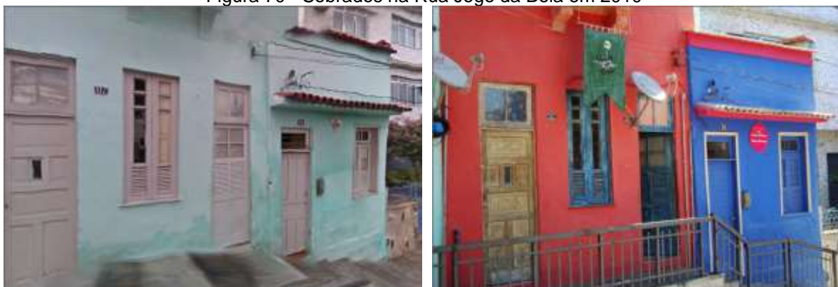
Figura 70 - Sobrados na Rua Jogo da Bola em 2010
