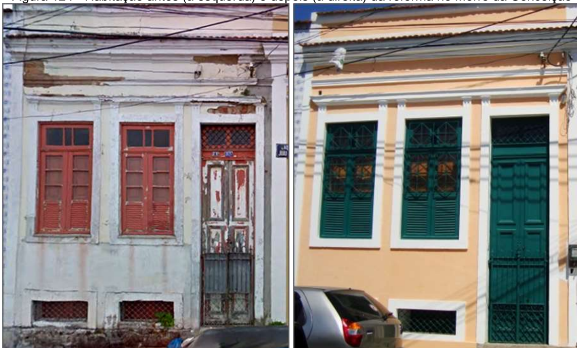
Figura 124 - Habitação antes (à esquerda) e depois (à direita) da reforma no Morro da Conceição
