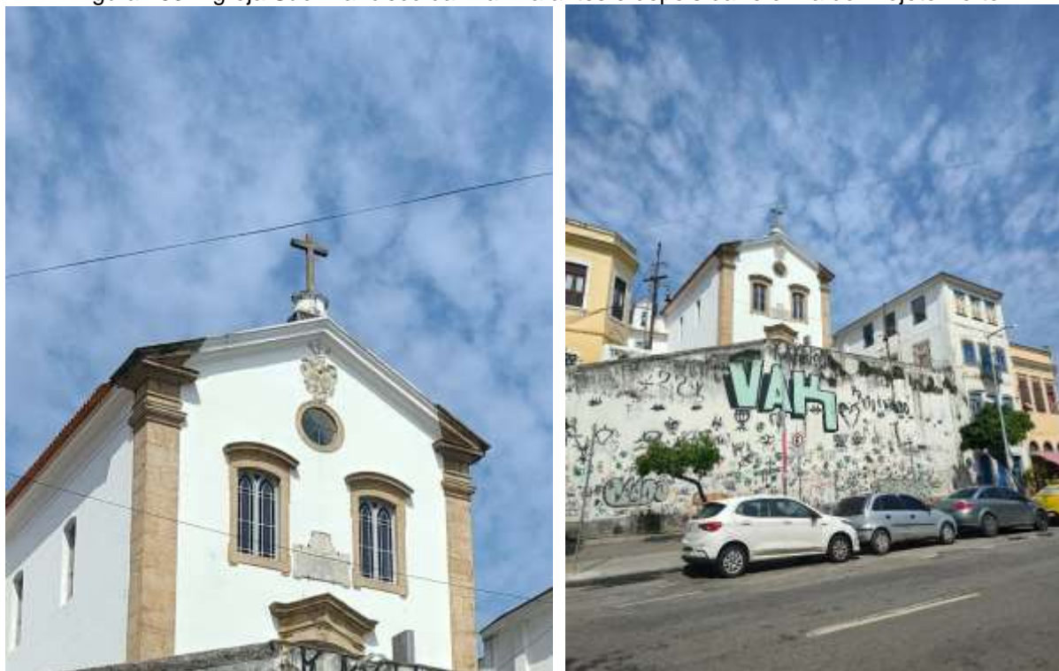
Figura 153 - Igreja São Francisco da Prainha antes e depois da reforma do Projeto Porto
