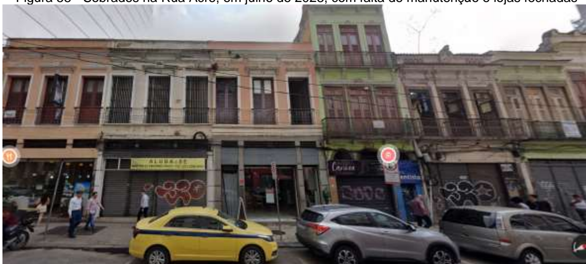
Figura 58 - Sobrados na Rua Acre, em julho de 2023, com falta de manutenção e lojas fechadas
