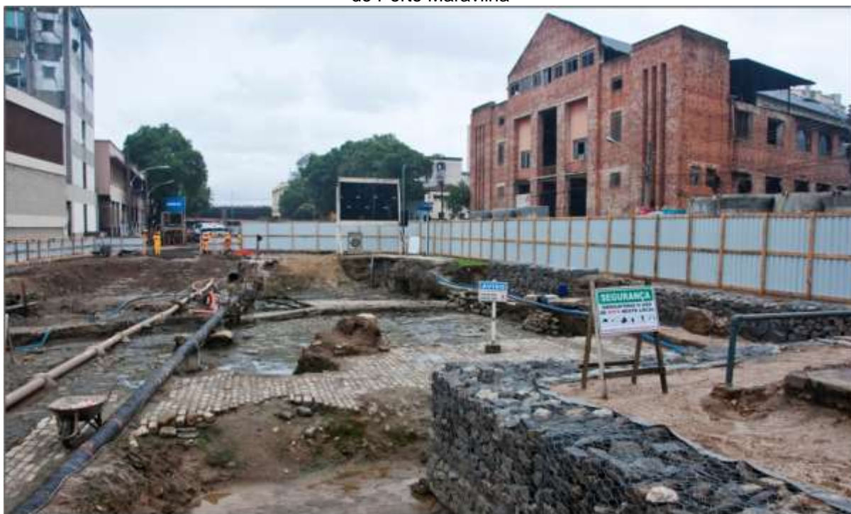
Figura 154 - Escavação e redescoberta do Cais do Valongo e Cais da Imperatriz, em meio às obras do Porto Maravilha
