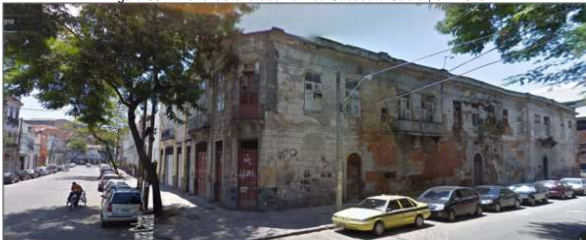
Figura 85 - Imóvel deteriorado na Rua Sacadura Cabral, em 2010
