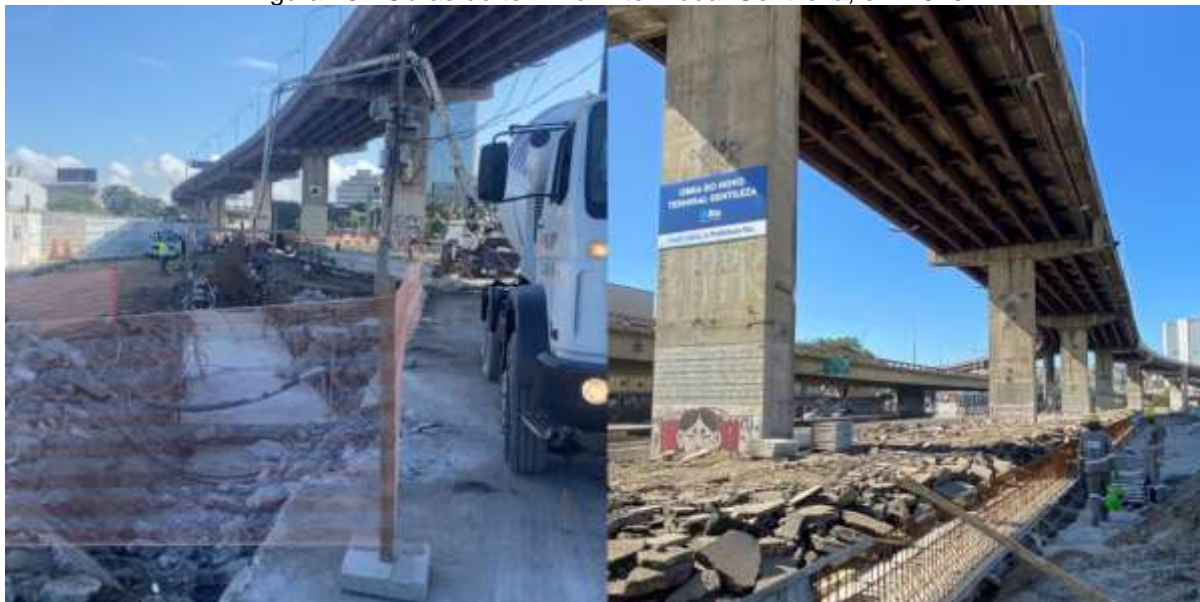
Figura 45 - Obras do terminal intermodal Gentileza, em 2023
