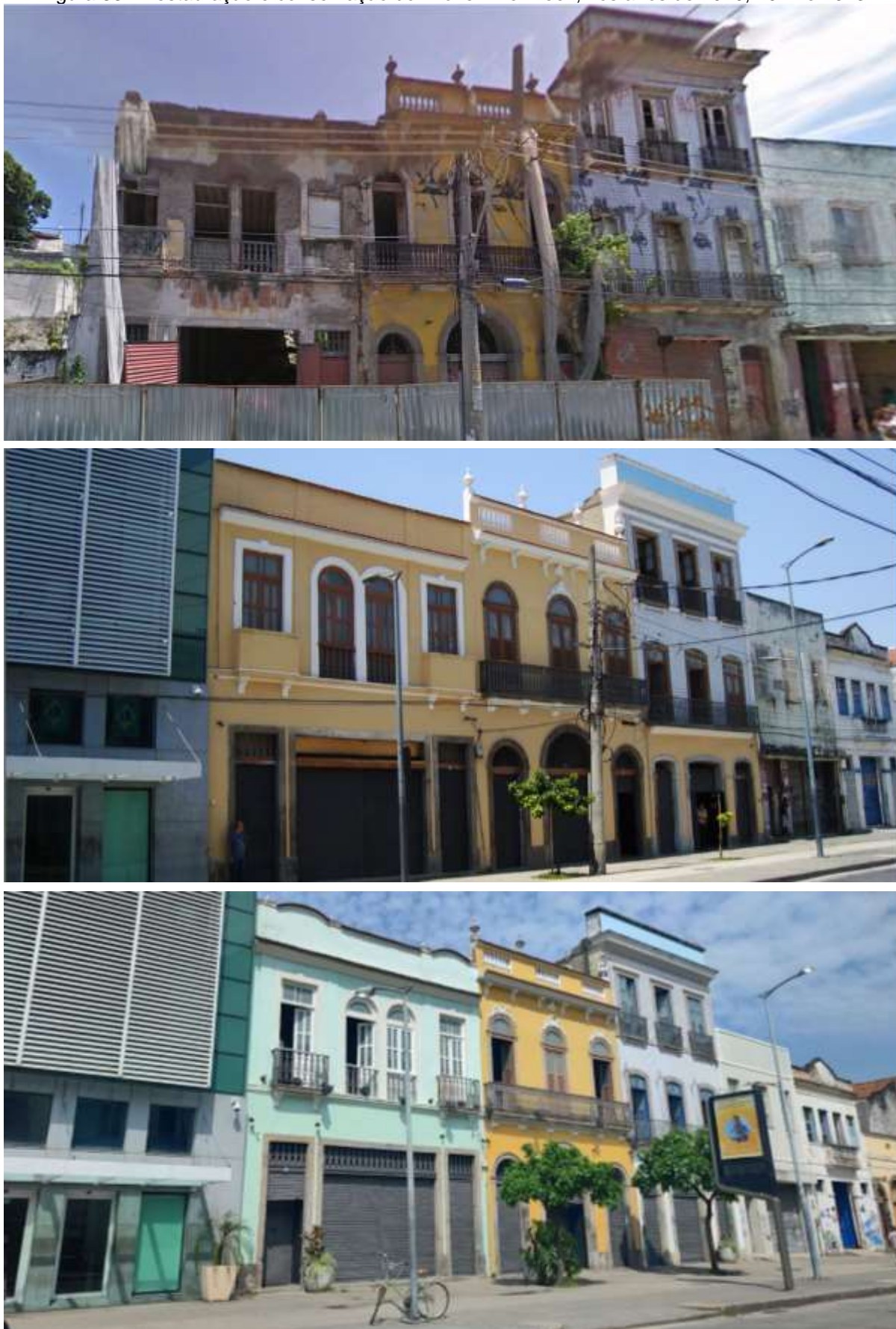
Figura 88 - Restauração e conservação do imóvel The Week, nos anos de 2010, 2014 e 2023
