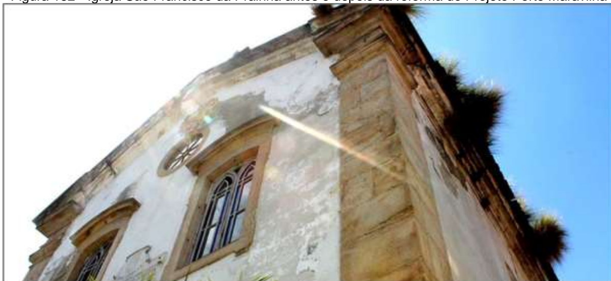
Figura 152 - Igreja São Francisco da Prainha antes e depois da reforma do Projeto Porto Maravilha
