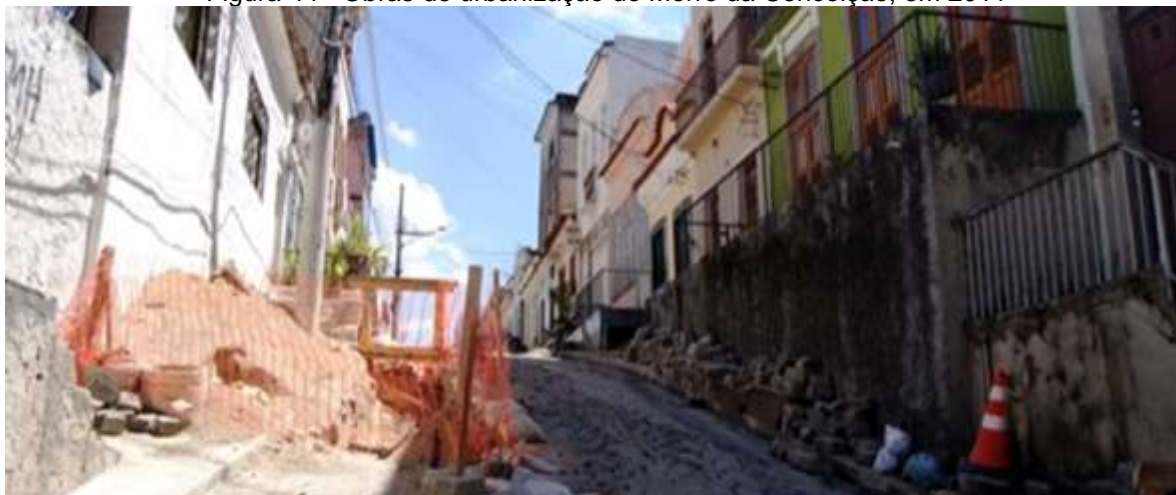
Figura 44 - Obras de urbanização do Morro da Conceição, em 2011
