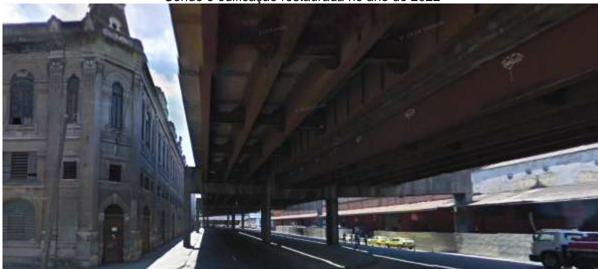
Figura 104 - Elevado da Perimetral e edificação degradada no ano de 2010 e Orla Prefeito Luiz Paulo Conde e edificação restaurada no ano de 2022
