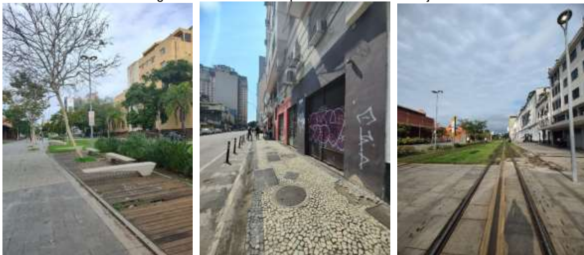
Figura 121 - Trechos do percurso sem manutenção
