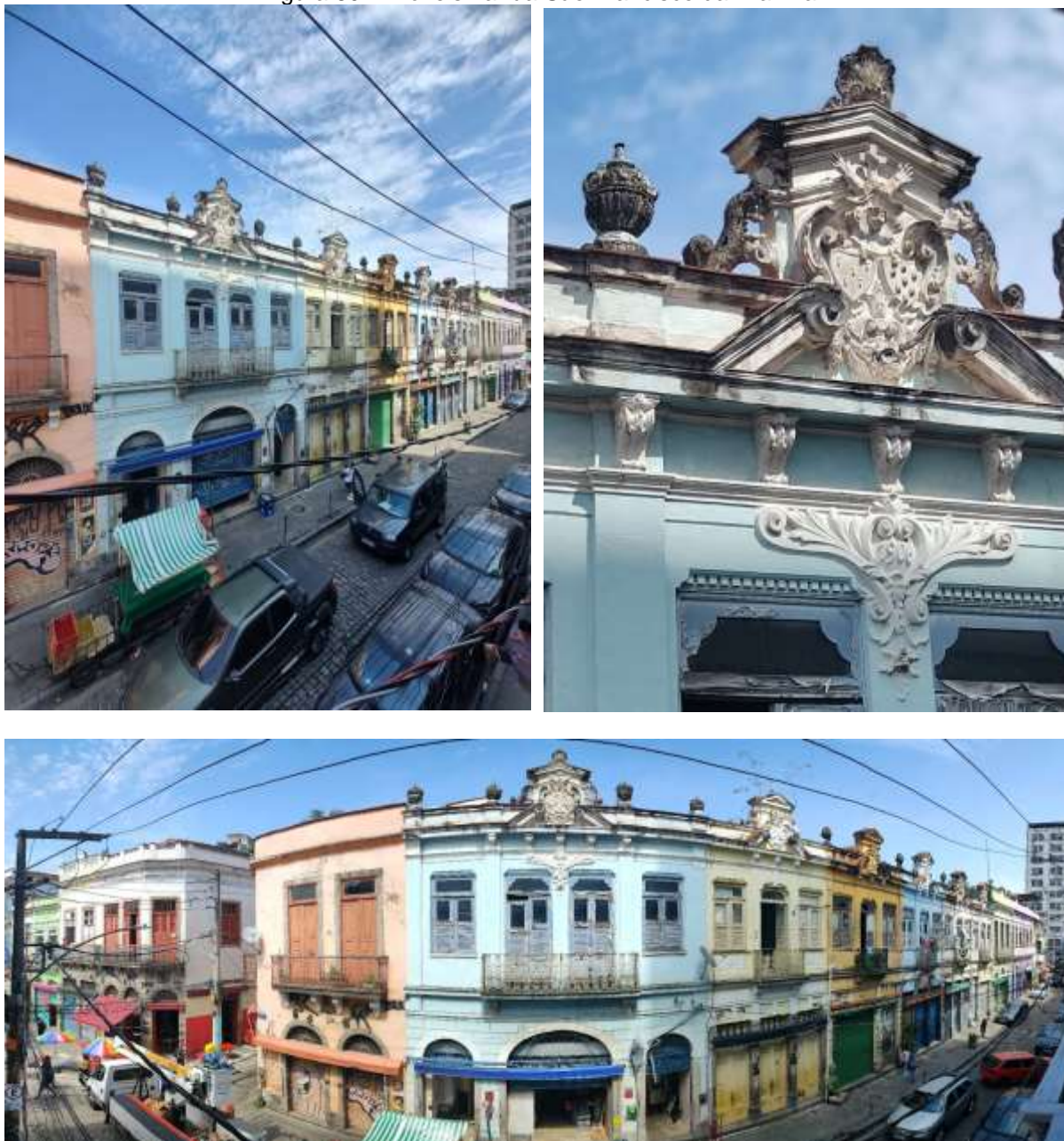
Figura 80 - Imóveis na rua São Francisco da Prainha
