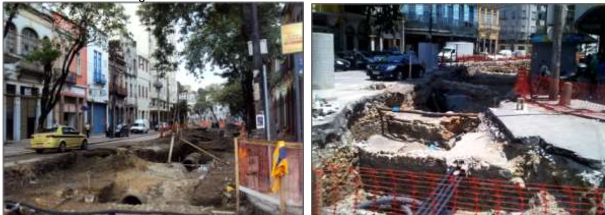
Figura 22 - Obras de infraestrutura na Rua Sacadura Cabral
