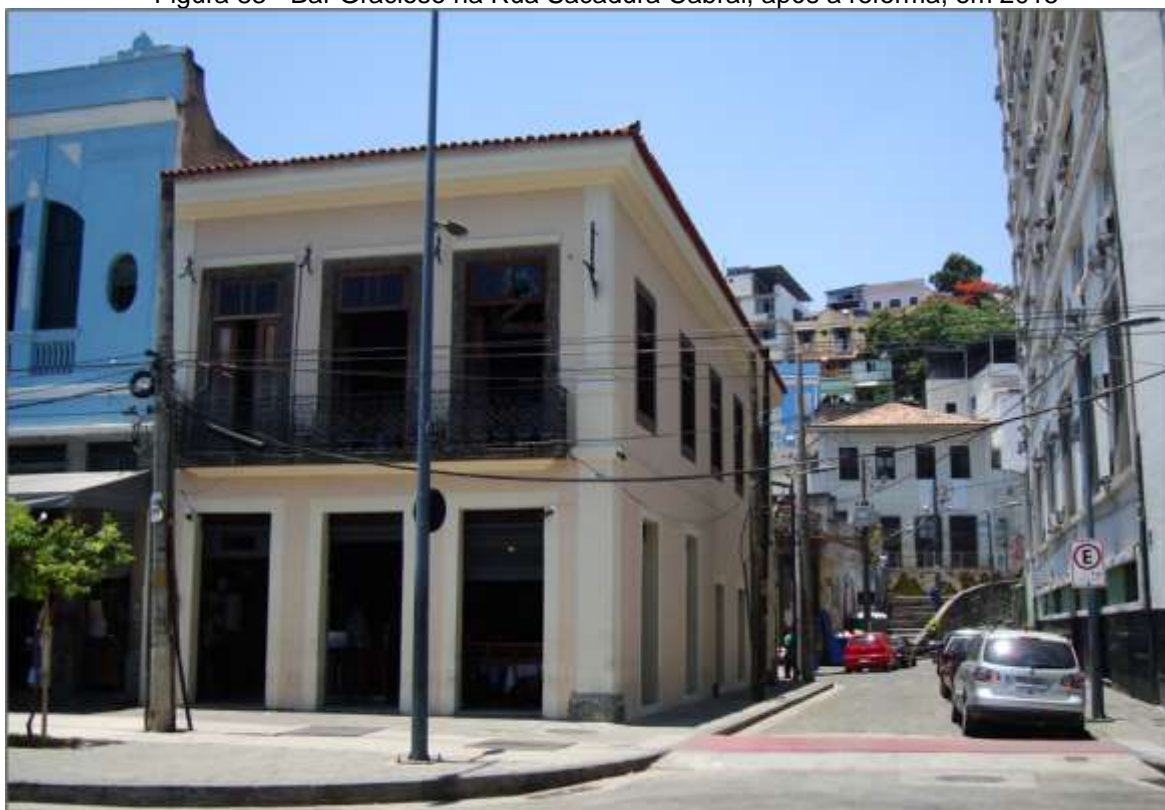
Figura 83 - Bar Gracioso na Rua Sacadura Cabral, após a reforma, em 2015
