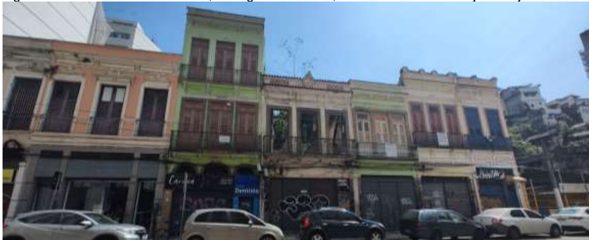
Figura 59 - Sobrados na Rua Acre, em agosto de 2023, com falta de manutenção e lojas fechadas
