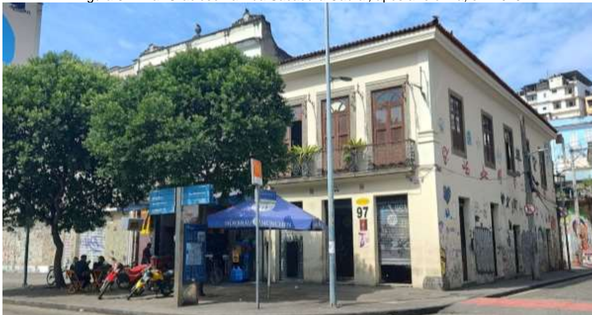
Figura 84 - Bar Gracioso na Rua Sacadura Cabral, após a reforma, em 2015
