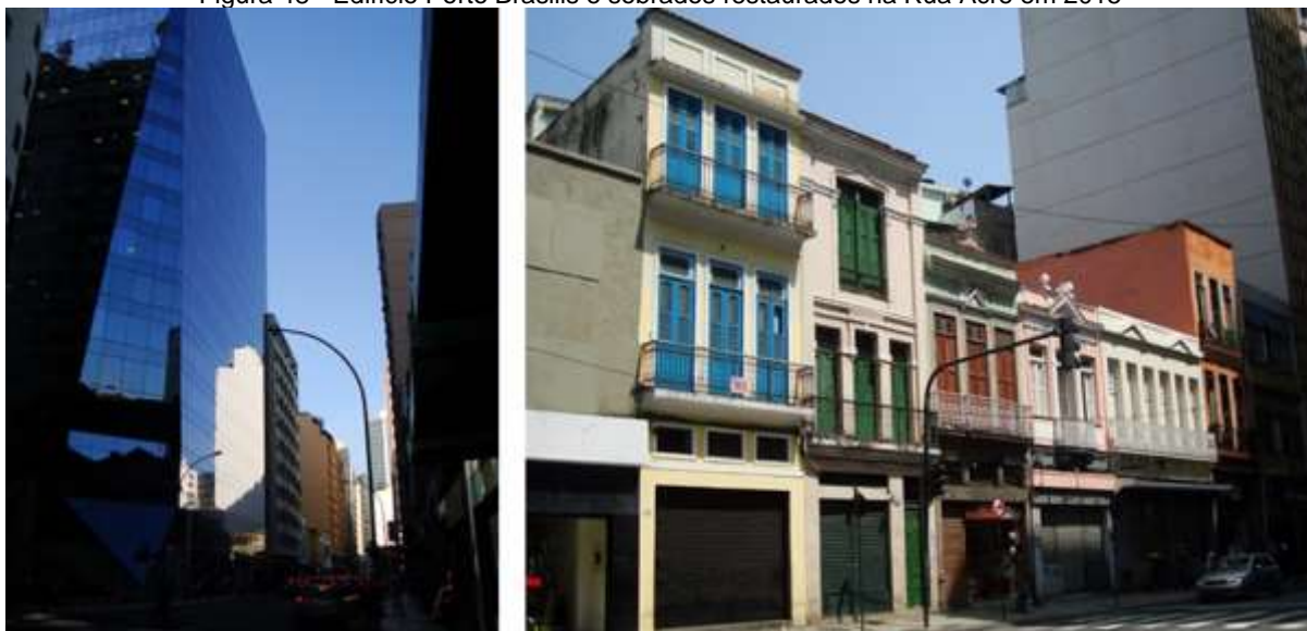
Figura 48 - Edifício Porto Brasil e sobrados restaurados na Rua Acre em 2015
