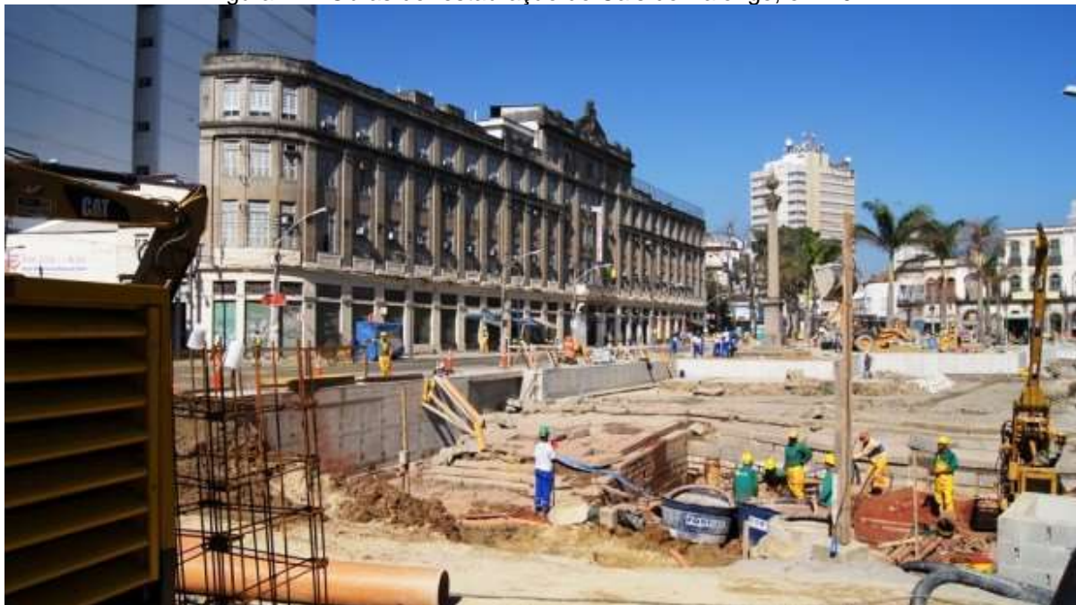
Figura 41 - Obras de restauração do Cais do Valongo, em 2011
