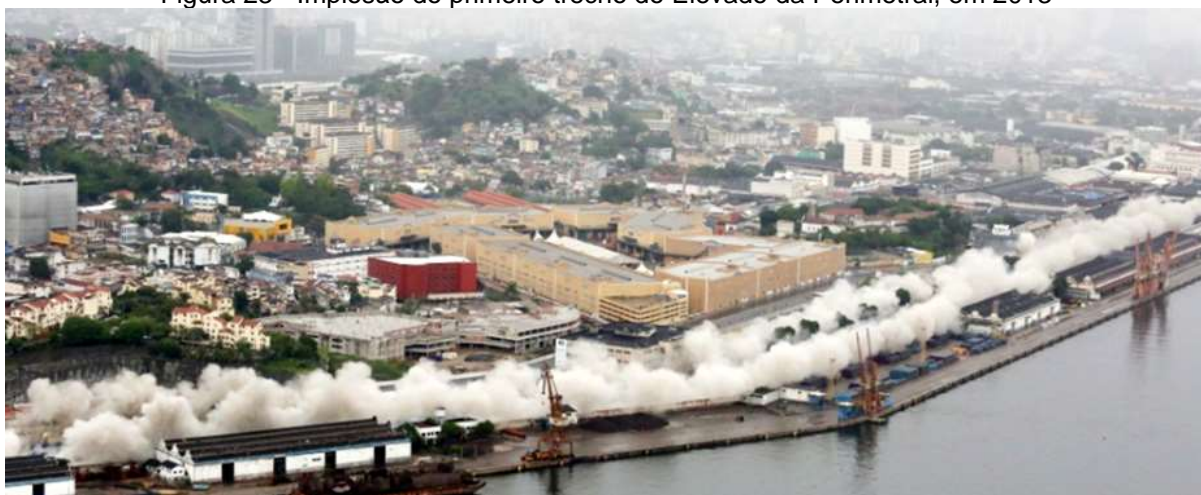
Figura 23 - Implosão do primeiro trecho do Elevado da Perimetral, em 2013
