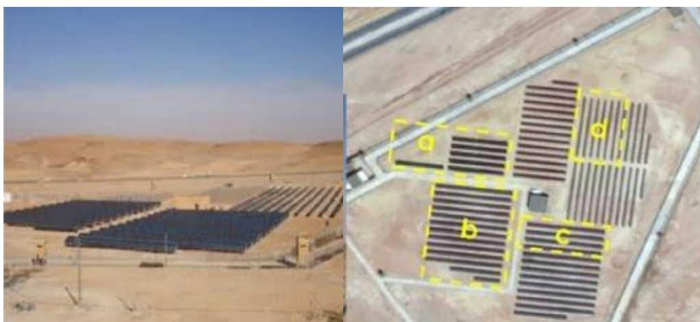
Figura 13 – Vista da planta piloto fotovoltaica em Ghardaia, Argélia. (a) Silício amorfo, (b) telureto de cádmio, (c) silício monocristalino e (d) silício multicristalino (adaptado de Chikh et al. , 2021).
