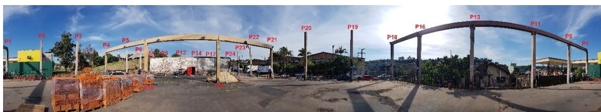
Figura 28 - Vista panorâmica da estrutura remanescente
