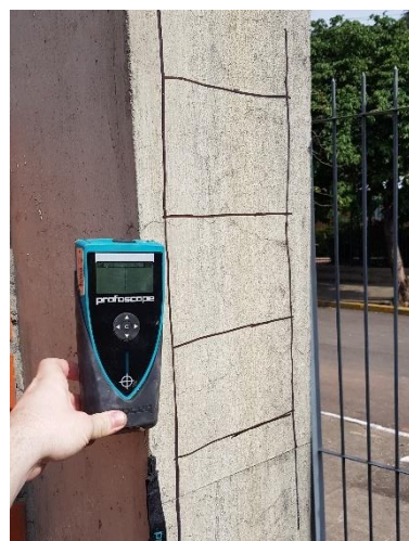
Figura 43: Demarcação das armaduras
