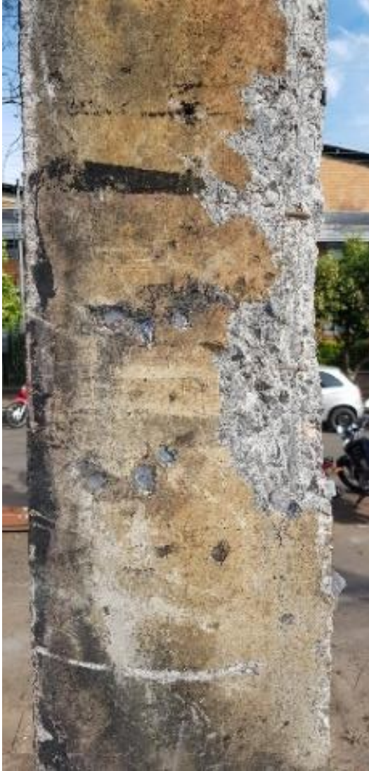
Figura 59 - Fechamento dos furos com silicone
