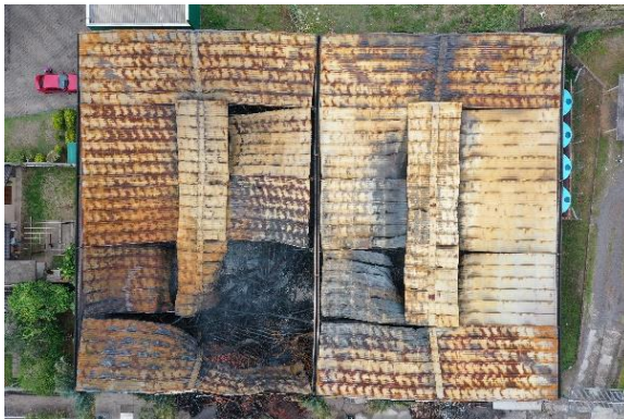
Figura 36 - Vista aérea da cobertura da edificação em análise
