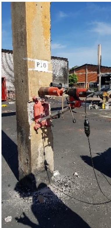
Figura 50 - Fixação da extratora P10
