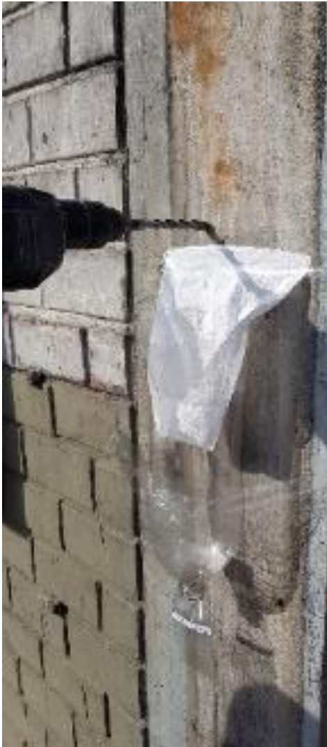
Figura 57 - Extração do pó P24
