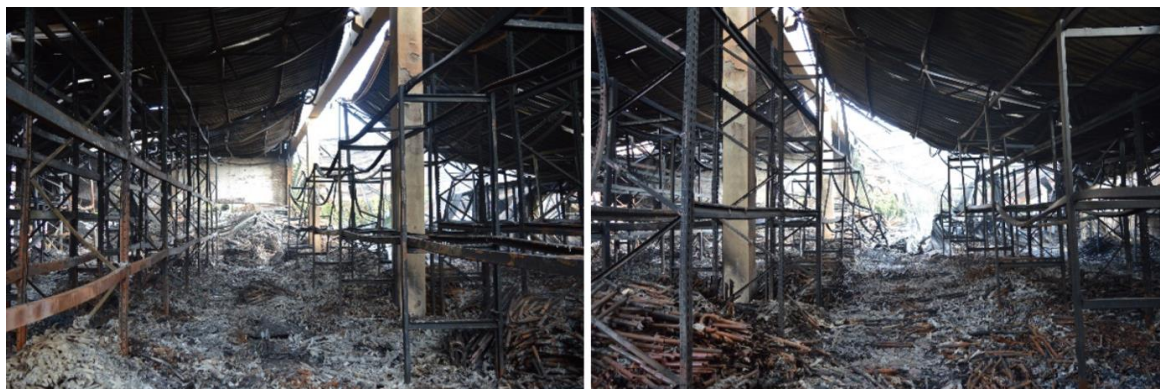
Figura 34 - Corredores sob a viga central
