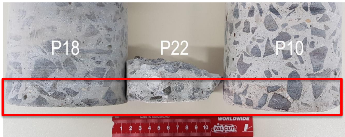
Figura 55 - Alteração visível da estrutura do concreto entre pilares
