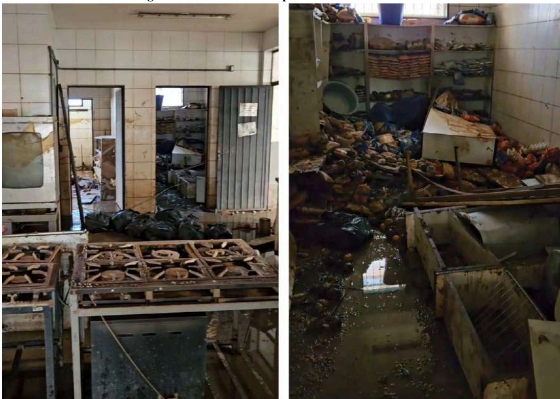
Imagens da cozinha e da despensa de alimentos da escola
