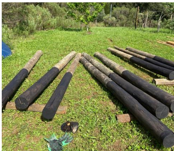
Figura 10. Vigas tratadas com hidroasfalto para estruturação da estufa.
