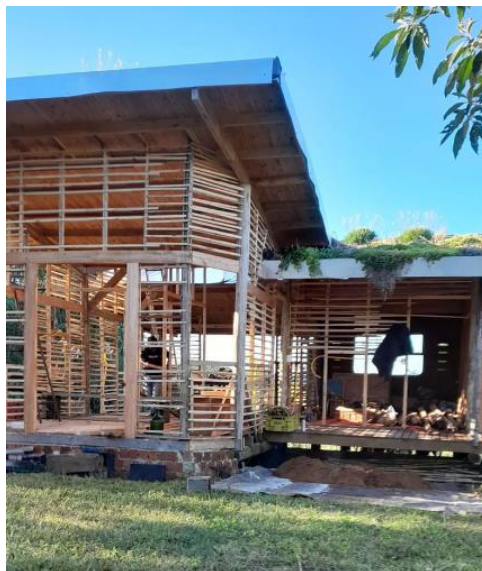
Figura 9. Obra da sede pelo método da bioconstrução.
