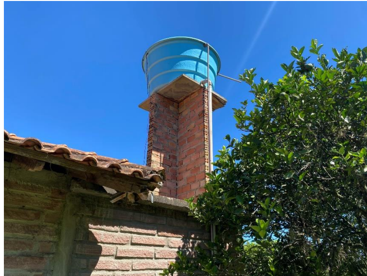
Figura 20 – Reservatório de água comumente encontrado na região.
