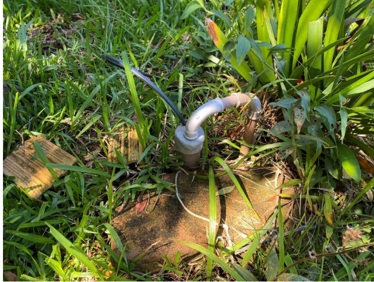
Figura 18 – Poço de pequeno diâmetro comumente encontrado na região.
