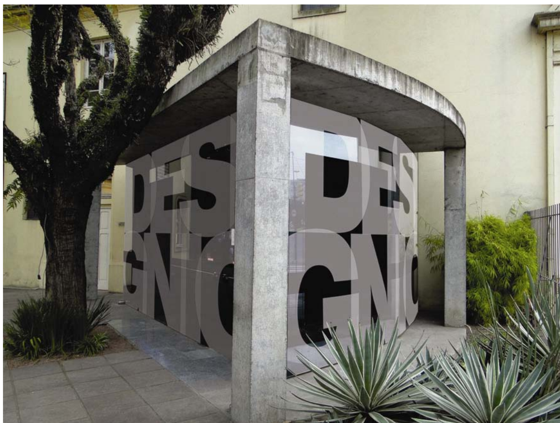
Figura 78 – Aplicação adesivos Acesso Principal.
