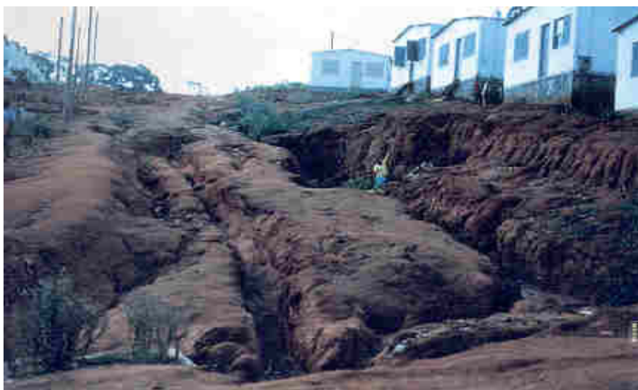
Figura 14: Drenagem incompleta no loteamento dos Peixotos, Viamão. Fonte: ABES/RS (2003)
