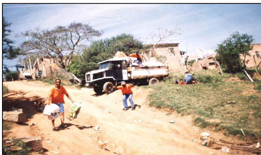
Figura 28: Formação de ravinas nas vias públicas não pavimentadas dificultando a trafegabilidade do caminhão da coleta de resíduos sólidos Fonte: Ciclo de Palestras - METROPLAN, 2005
