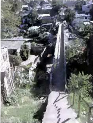
Figura A.11 Vista da ponte
