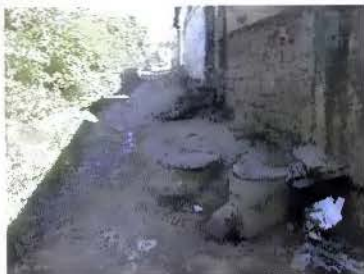
Figura A.8 Trecho do Arroio à montante da ponte – redes de esgoto sanitário existentes
