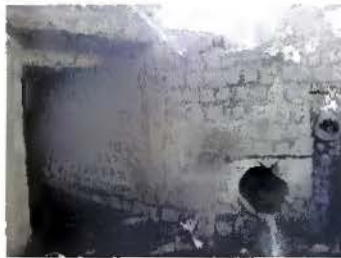
Figura A.15 Chegada de tubulação pluvial
