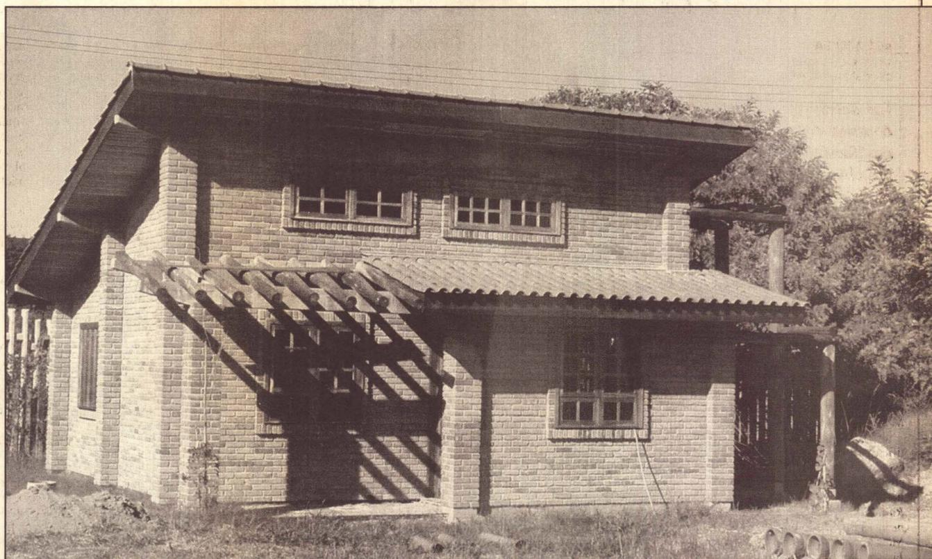
reciclando chapas de fotolitos, que funciona como uma barreira à passagem de calor.
