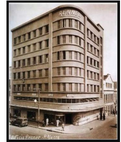
Figura 4: Foto do edifício Renner no centro de Porto Alegre, década de 1930. Fonte: Acervo Museu de Porto Alegre Joaquim Felizardo. 4682f
