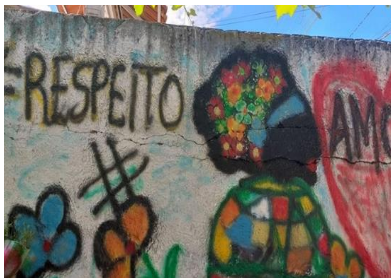
Figura 3 – Pintura no muro da escola
