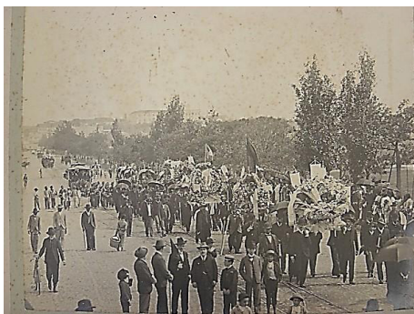
Figura 17 – Fotografia do aniversário de morte de Julio de Castilhos (legenda atribuída). Data: 25/10/1904.
