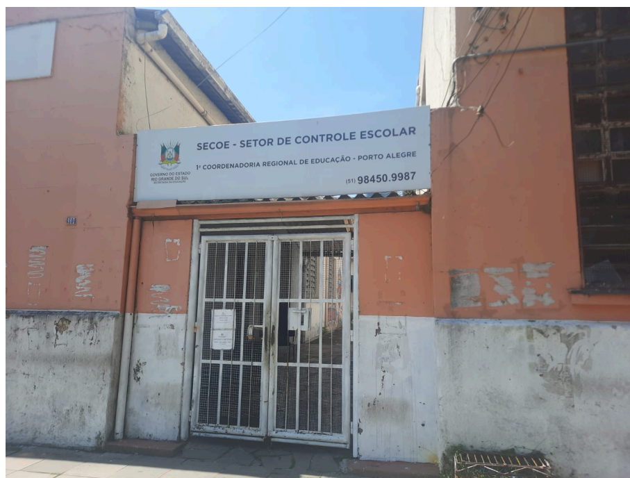
Figura 4 - Fachada atual do antigo prédio da Escola Estado do Rio Grande do Sul
