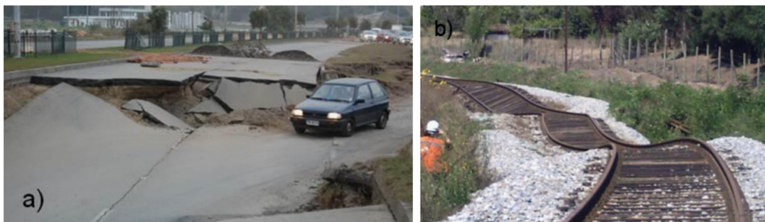
Figura 2.5 – Assentamentos pós-liquefação do solo, Chile 2010 (VERDUGO; GONZÁLEZ, 2015)
