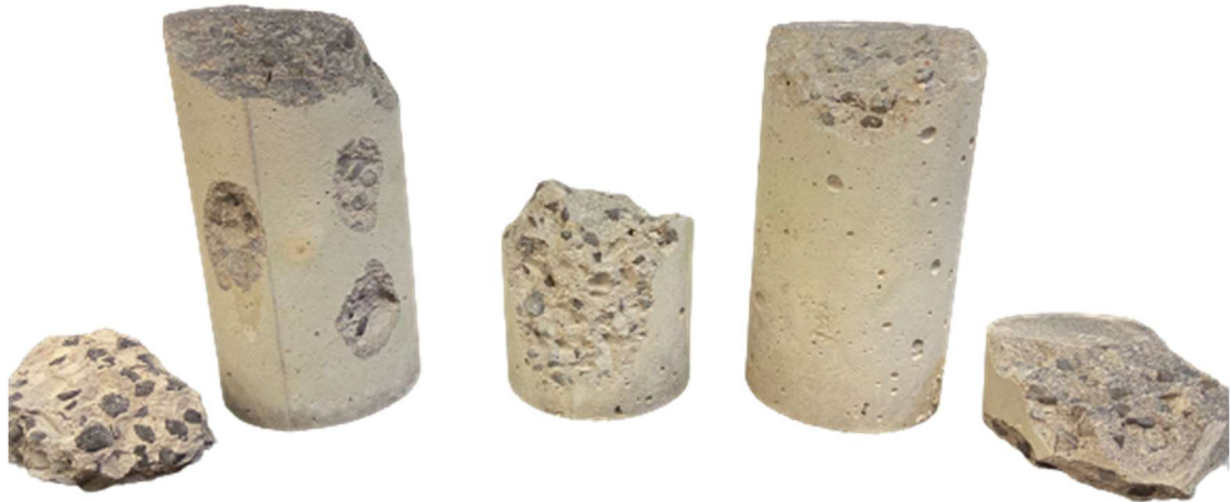
Figura 40 – Análise de spalling do CAA-RCV
