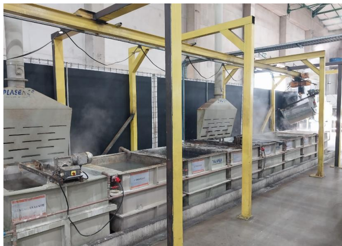
Figura 22: Linha para o processo de lubrificação dos tubos.
