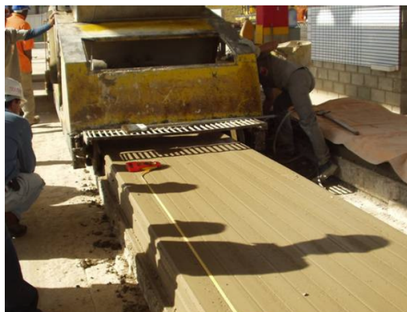
Figura 2.9 – Concretagem de lajes alveolares
