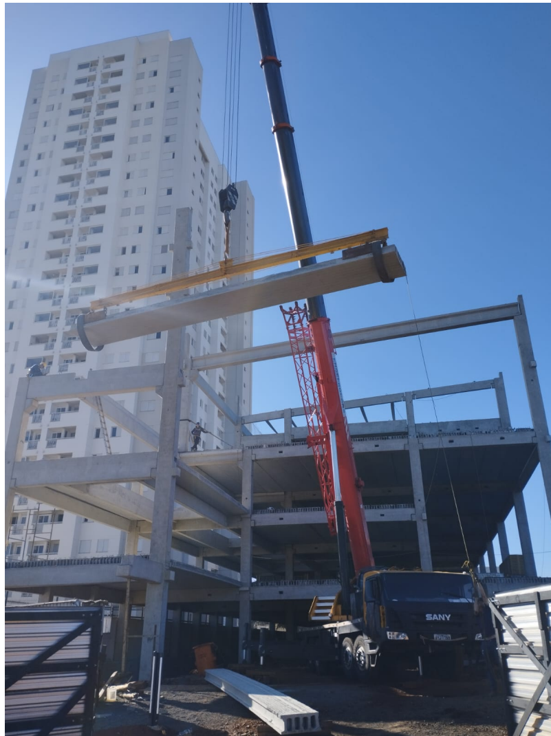
Figura 2.11 – Içamento e posicionamento das lajes
