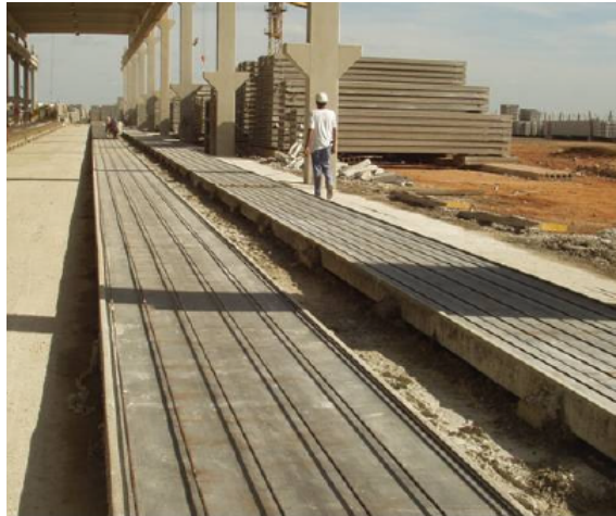
Figura 2.7 – Cabos de protensão
