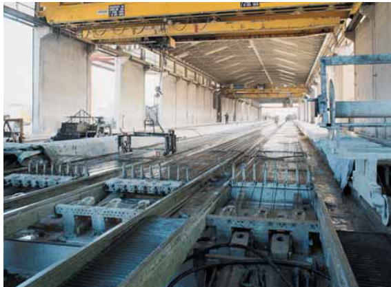
Figura 2.8 – Pista de protensão
