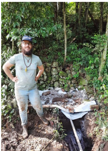
Figura 3 - Estagiário auxiliando na construção de estrutura para a conservação de nascente.
