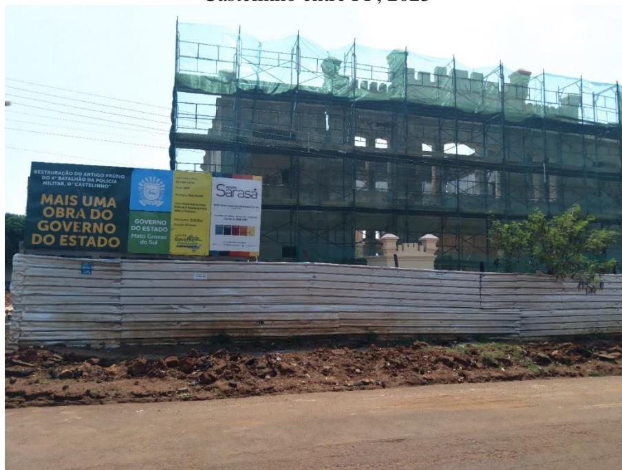
Figura 15 - Placa da obra de restauração do prédio do 4º Batalhão da Polícia Militar, Castelinho entre PP, 2023
