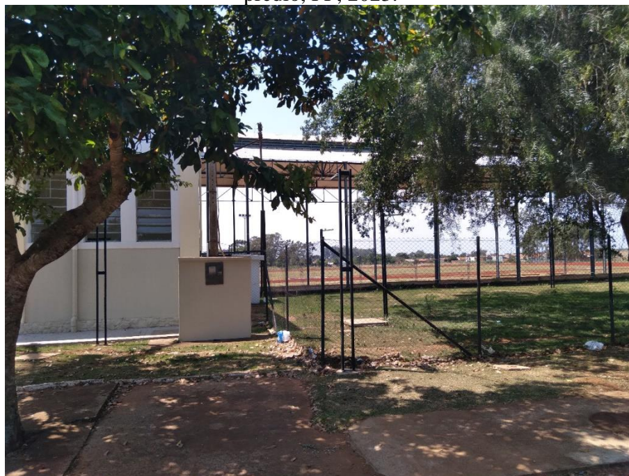
Figura 23 - Lateral do prédio da FUNCESPP vazio em função das reformas estruturais do prédio, PP, 2023.
