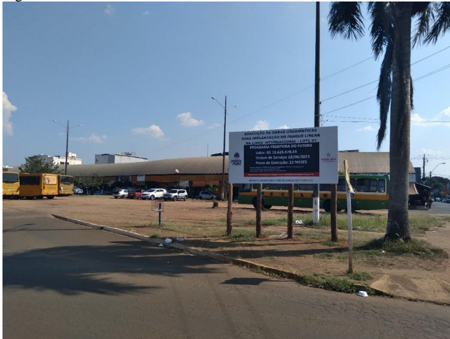
Figura 11 - Placa da obra na Linha Internacional, PJC-PP, PTU - 2023.
