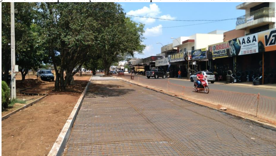
Figura 28 - Base para calçamento de rua próxima à Linha Internacional - PTU, 2023
