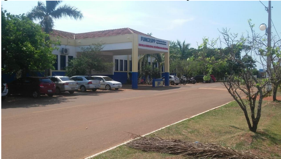
Figura 21 - Fachada da FUNCESPP anterior ao período da reforma em PP, 2019.
