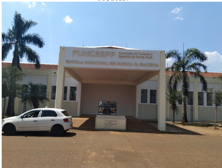
Figura 22 - Fachada da FUNCESPP fechada em função das reformas estruturais do prédio, PP, 2023.
