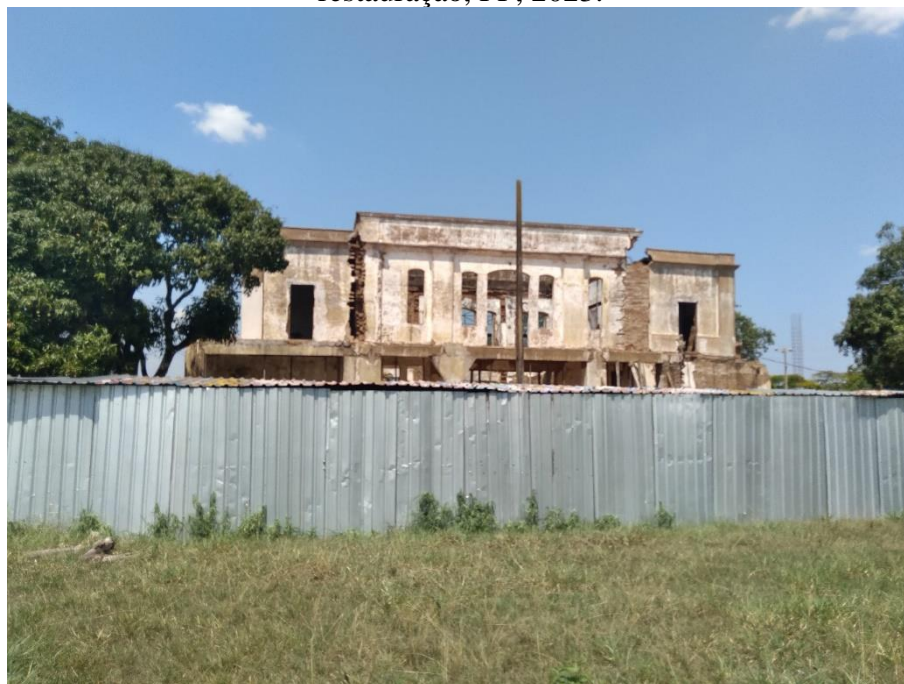
Figura 17 - Prédio do 4º Batalhão da Polícia Militar, Castelinho (fundos) em fase de restauração, PP, 2023.
