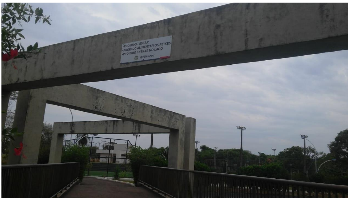
Fotografia 33. Parque dos Ervais, travessia sobre o lago, 2019
