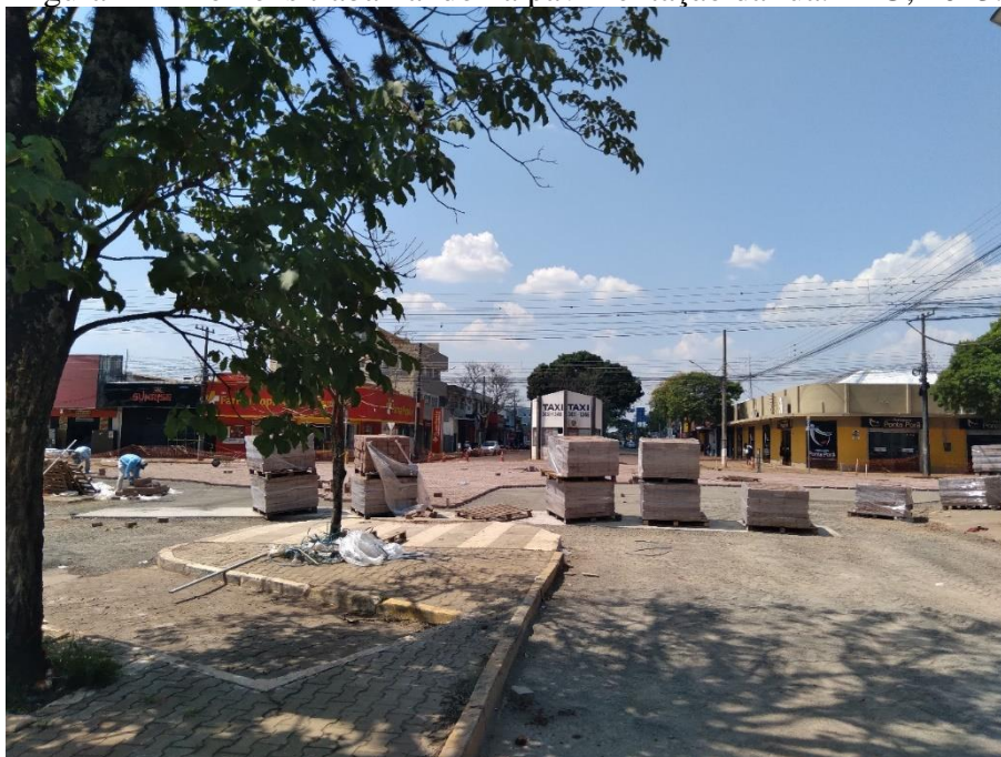
Figura 12 - Homens trabalhando na pavimentação da rua. PTU, 2023.
