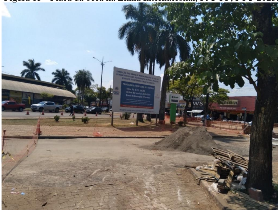
Figura 13 - Placa da obra na Linha Internacional, PJC-PP, PTU 2023.
