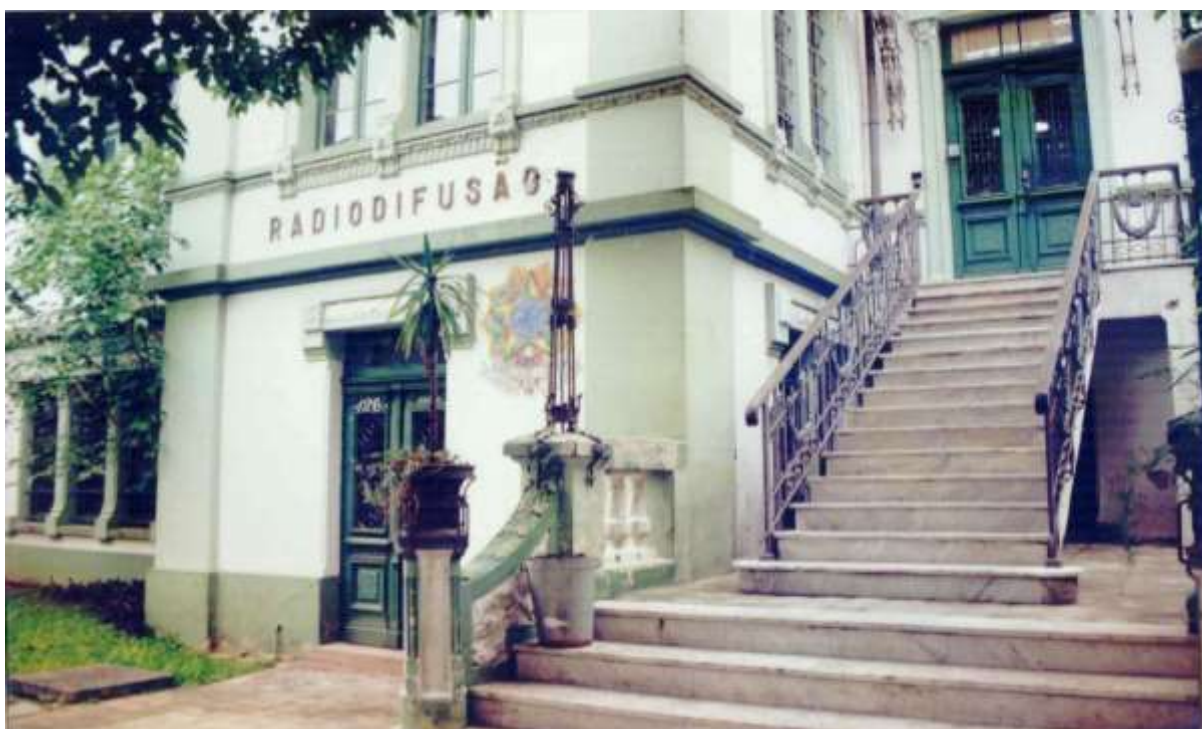
Prédio da emissora antes da restauração (Fonte: Arquivo Rádio da Universidade)
