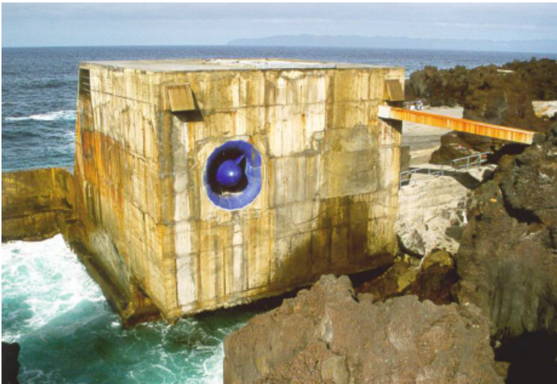
Figura 3.3: Dispositivo instalado na Ilha do Pico [27].
