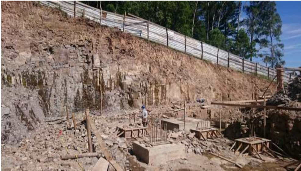
Figura 6 - Vista em sentido noroeste da face oeste do Talude 3.
