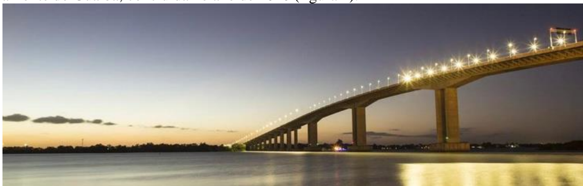
Figura 1 – Nova Ponte do Guaíba, no estado do Rio Grande do Sul, Brasil.
