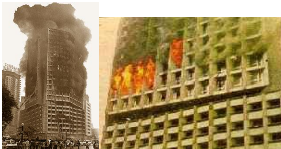
Figura 4- Incêndio Edifício Joelma
