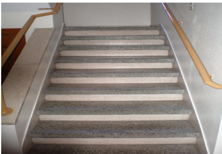
Figura 13 - Corrimão tubular e fita antiderrapante das escadas
