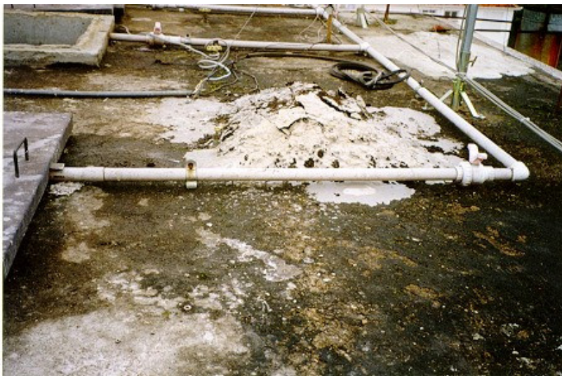
Figura 4 – Obstáculos para impermeabilização
