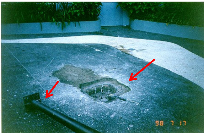
Figura 10 – Fixação de luminária
