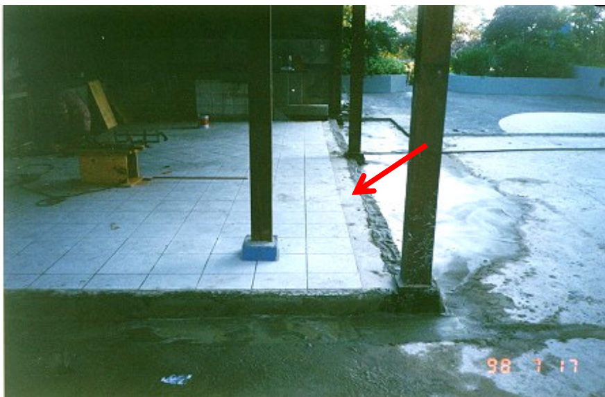
Figura 6 – Preparação para encaixe da impermeabilização
