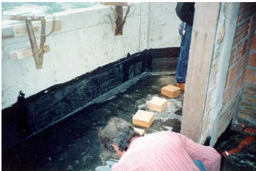
Figura 14 – Teste de estanqueidade
