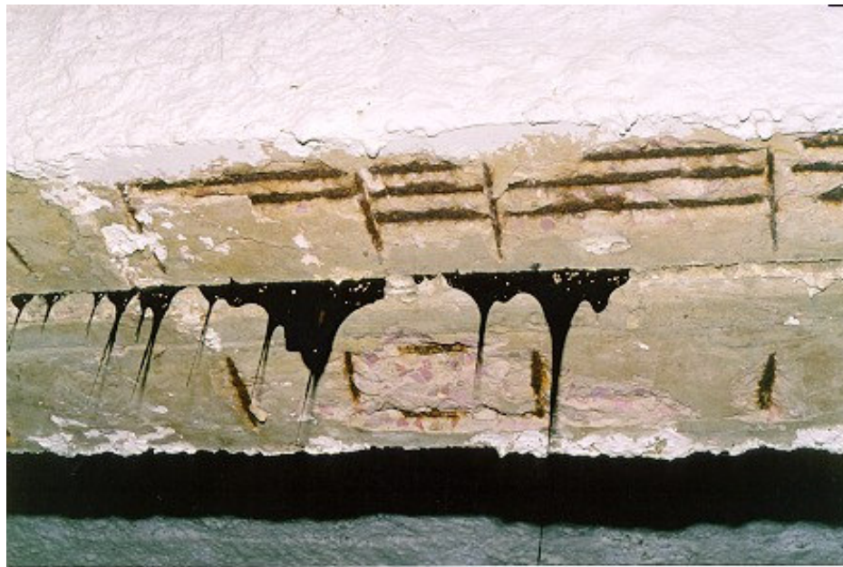
Figura 13 – Vedação de junta
