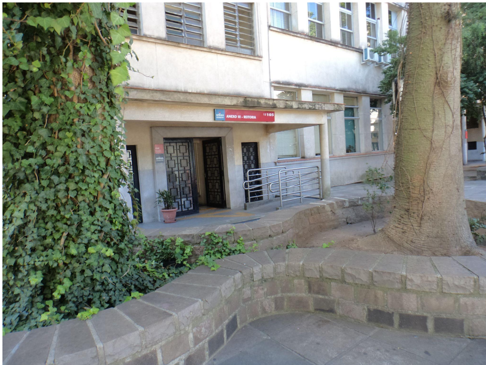
Figura 15 - Atual Anexo III da Reitoria da UFRGS
