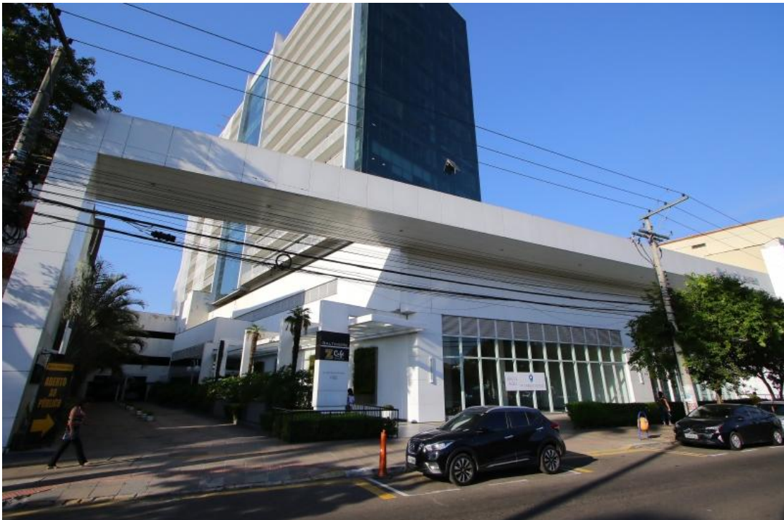
Figura 6 - Prédio comercial que hoje ocupa o terreno do antigo Cine Baltimore
