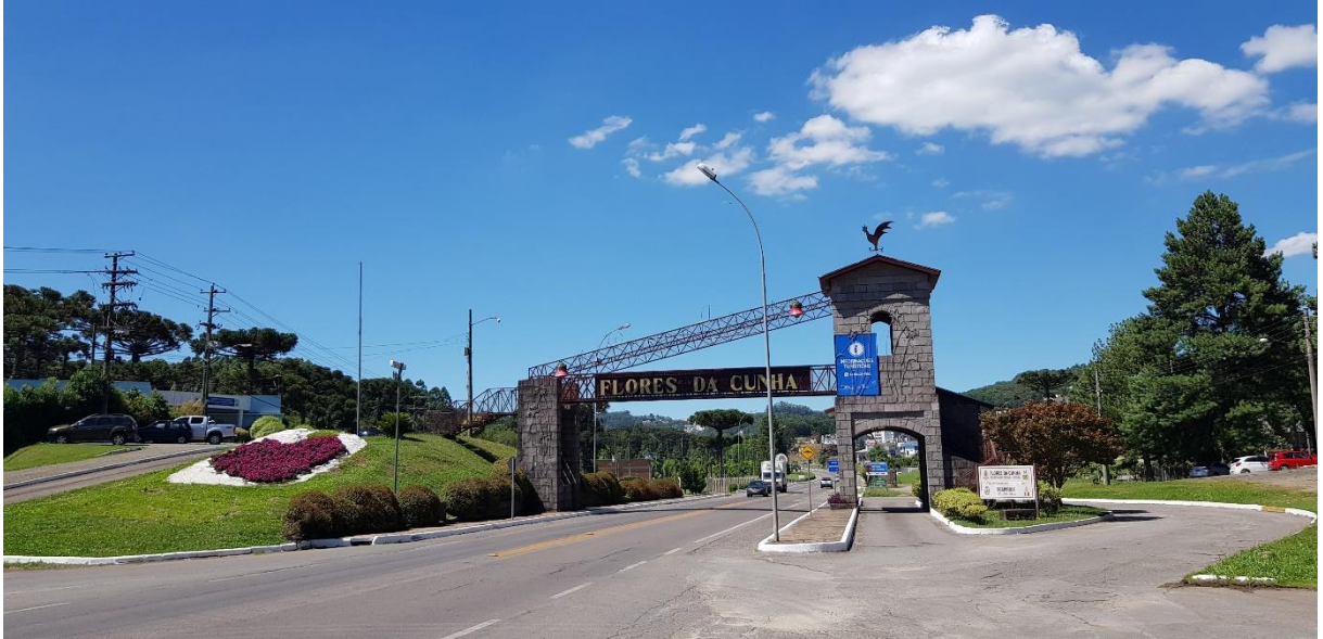
Figura 5 - Foto do pórtico de acesso sul de Flores da Cunha
