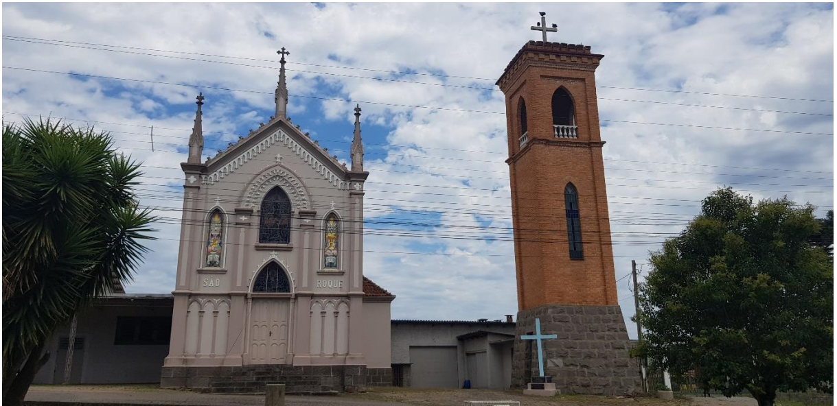
Figura 46 - Foto da Capela e do Campanário de São Roque.
