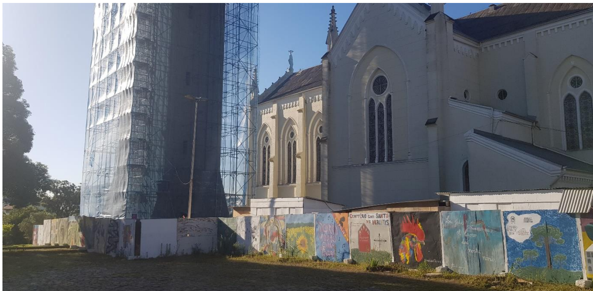
Figura 19 – Tapumes ilustrados no entorno do Campanário em obras.
