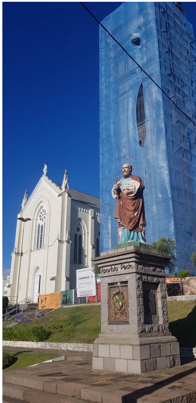
Figura 18 – Foto do Campanário de Flores da Cunha em obras.
