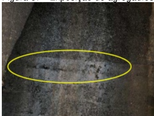
Figura 37 - Exposição de agregadfos
