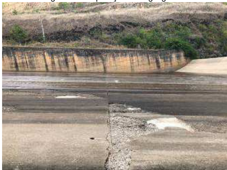
Figura 8 - Exposição de agregados
