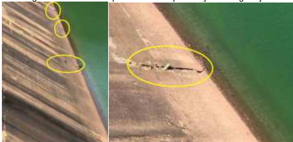
Figura 24 e 25 - Deslocamento e presença de vegetação
