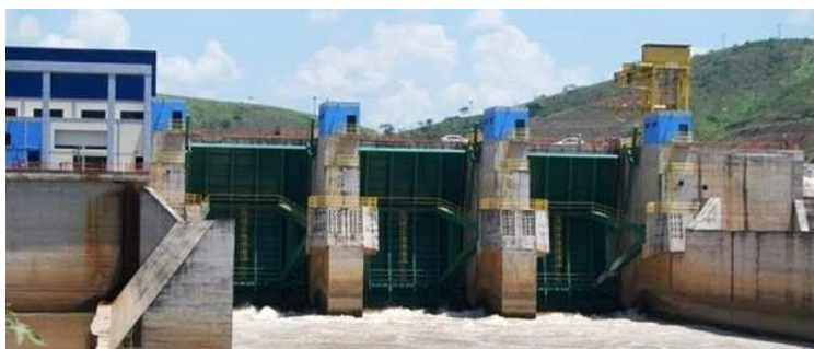
Figura 58 - Vertedouro com comportas
