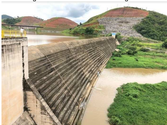
Figura 57 - Vertedouro em degraus
