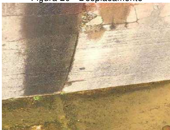
Figura 20 - Desplacamento
