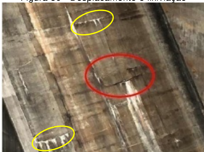
Figura 50 - Deslocamento e lixiviação
