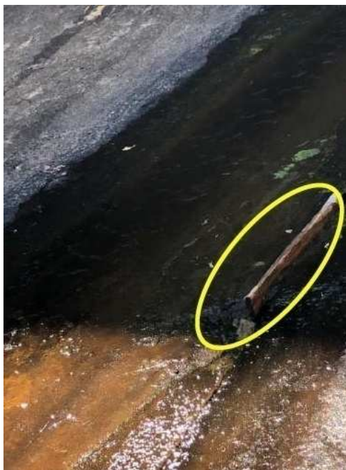
Figuras 32 e 33 – Deslocamento com exposição de agregados: vão 12
