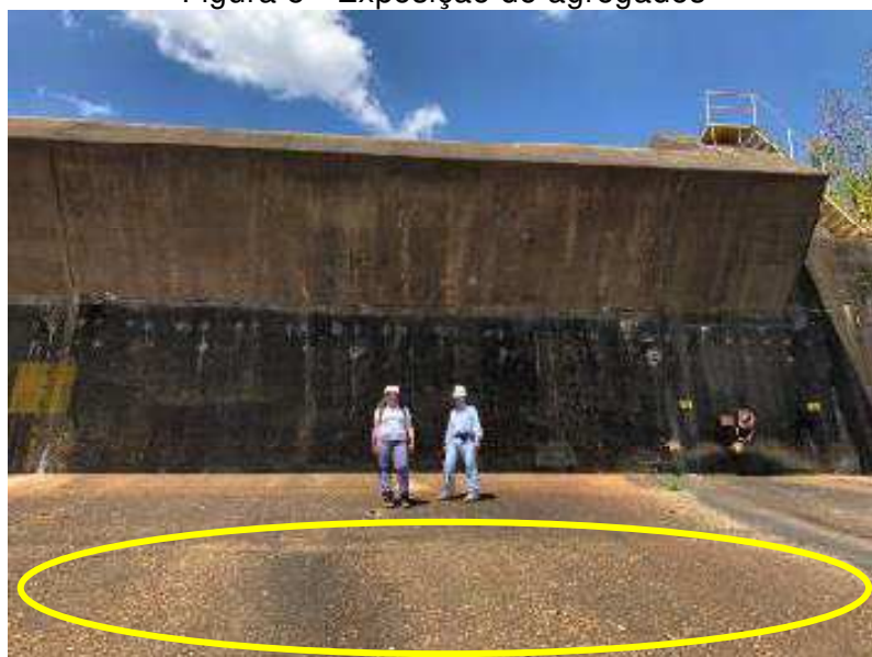
Figura 5 - Exposição de agregados
