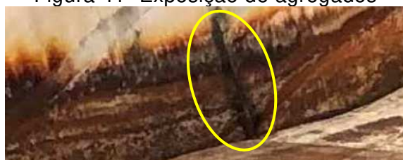
Figura 41 -Exposição de agregados
