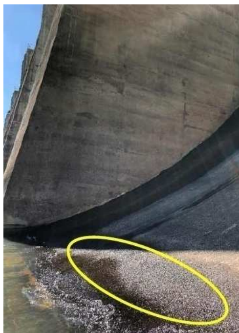
Figura 31 – Exposição de agregados: vão 8
