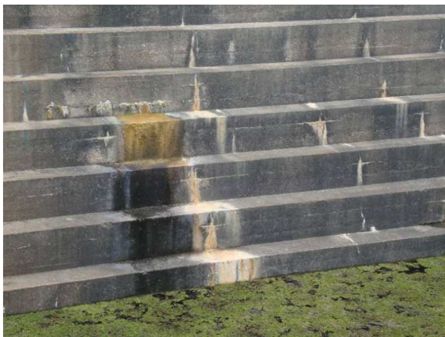
Figura 3– Surgência em vertedor em degraus
