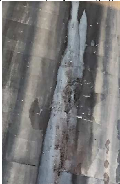
Figura 29 - Exposição de agregados
