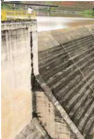
Figura 63 - Fissuras aleatórias
