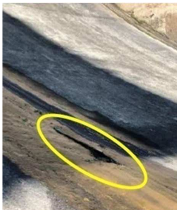
Figuras 32 e 33 – Deslocamento com exposição de agregados: vão 12
