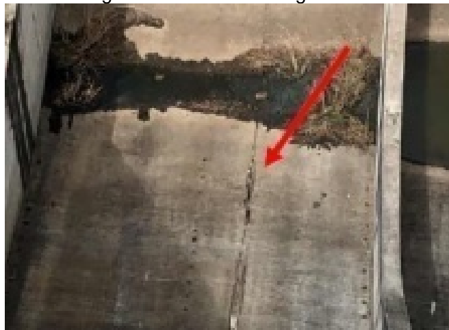
Figura 49 - Fissura longitudinal
