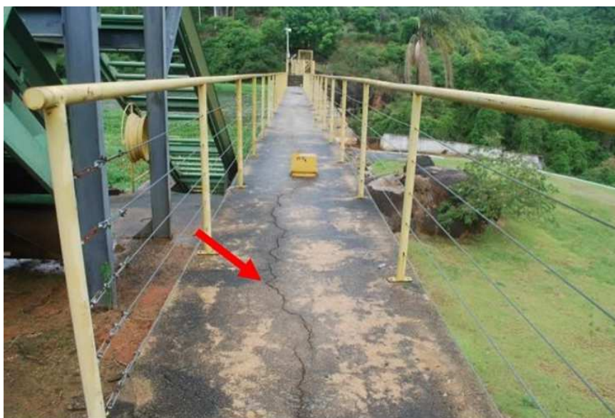
Figura 4 – Fissura longitudinal
