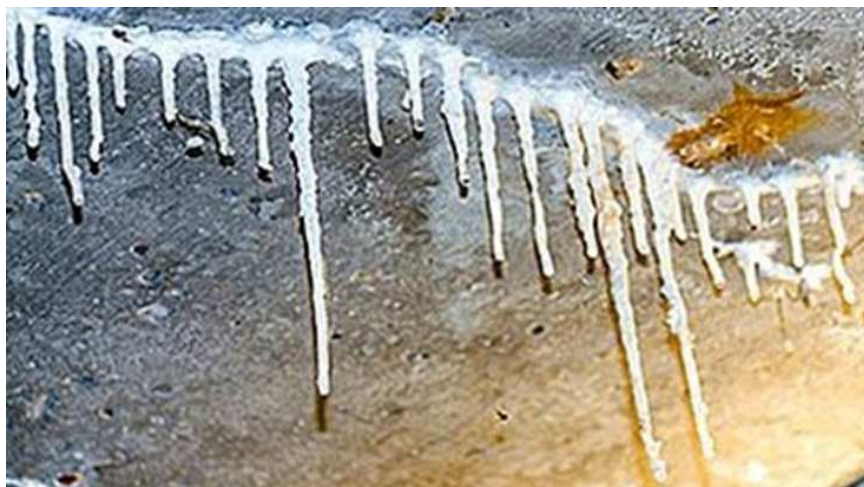
Figura 7 – Estalactite oriunda de lixiviação
