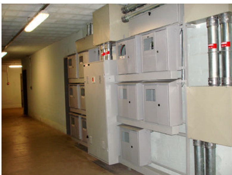
Imagem 10 – Centro de medição em BT – Fonte: Arquivo Shopping
