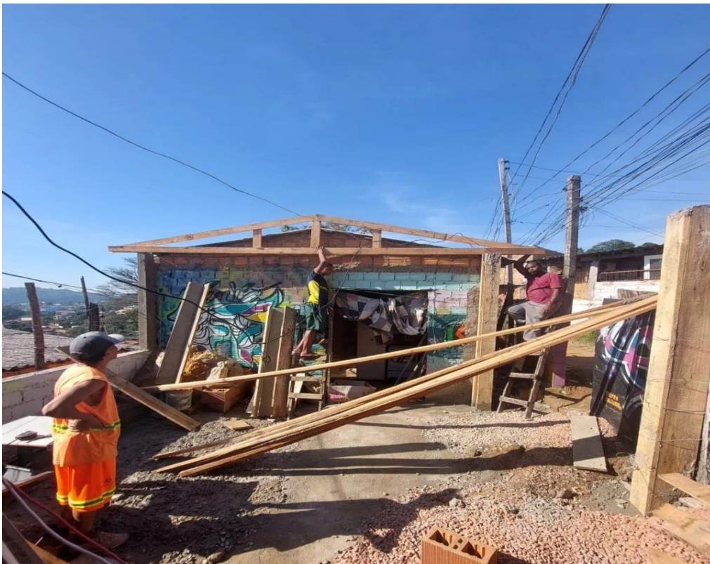
Figura 21 – O Galpão em construção
