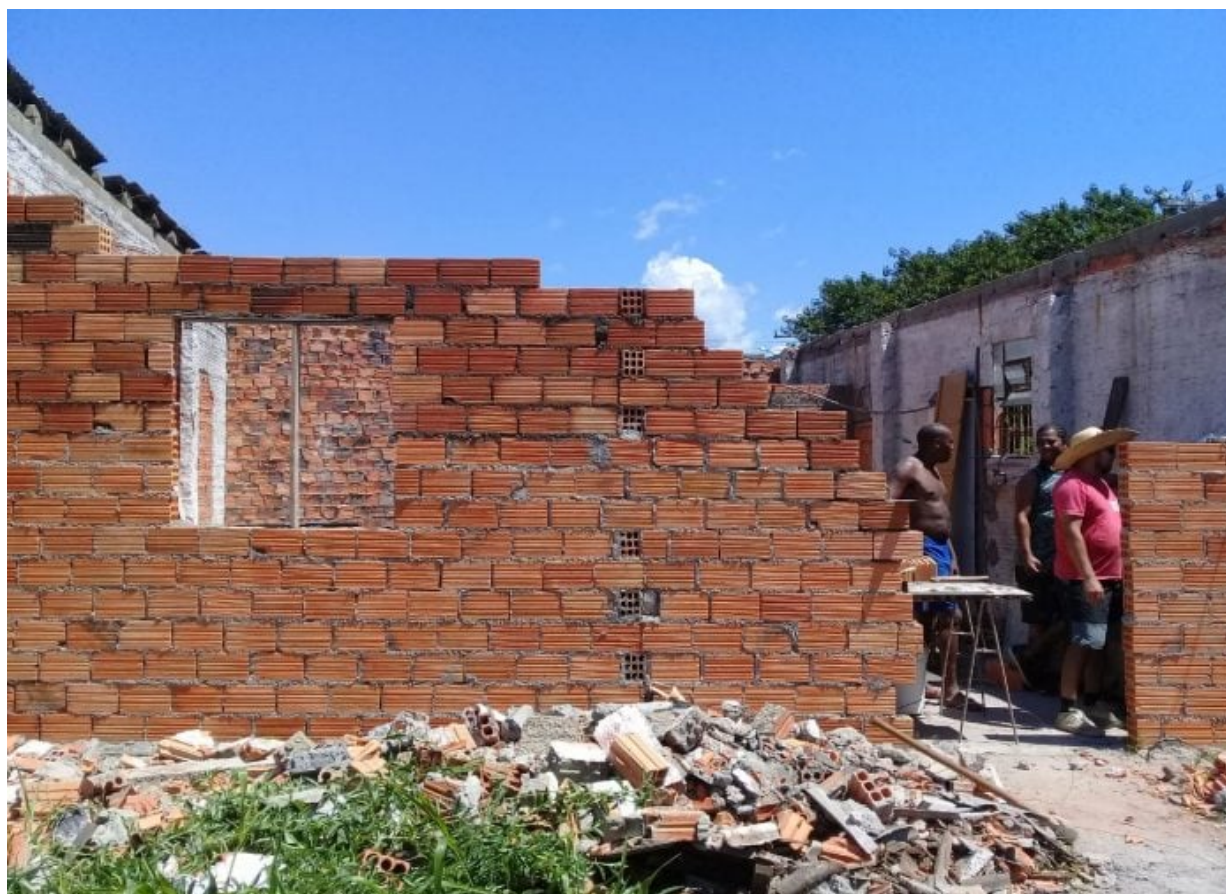
Figura 10 – Casa de Hip Hop de Criciúma em obras
