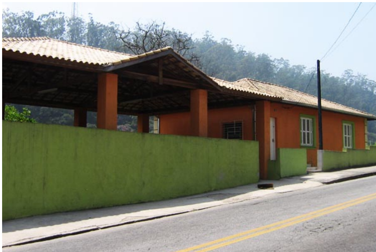
Figura 14 – Prédio da Casa de Hip Hop de Ribeirão Pires
