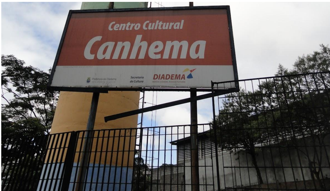
Figura 4 – Antiga fachada da Casa de Diadema (SP)
