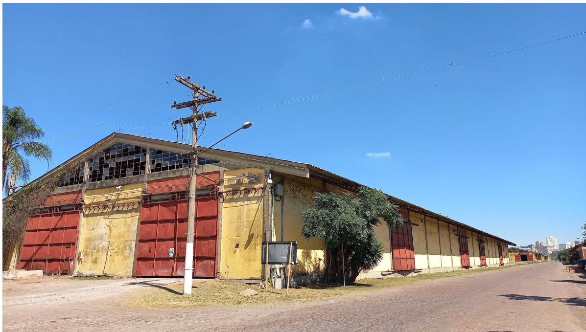
Figura 12 - Subsistema de armazenamento fechado.
