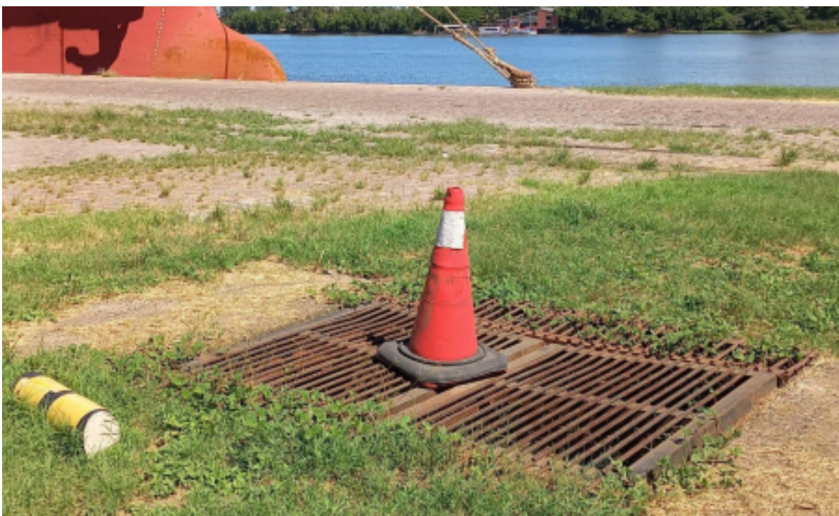
Figura 4 - Ponto de captação de água bruta dentro da Poligonal do Porto Organizado.
