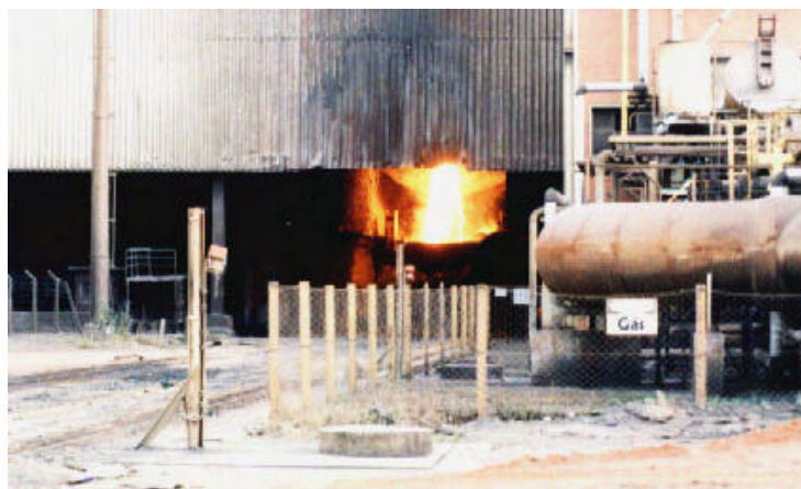
FIGURA 18 Vista da área externa da aciaria da usina siderúrgica mostrando o vazamento da escória líquida do conversor LD para o pote de escória
