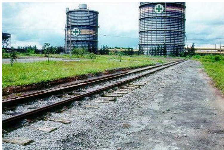
FIGURA 12 Lastro ferroviário construído com escória LD - AÇOMINAS/MG
