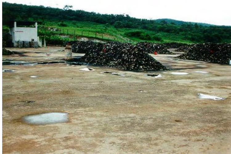
FIGURA 14 Piso de depósito de lixo construído com escória LD – Ouro Branco/MG
