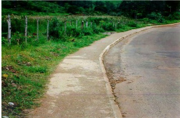
FIGURA 13 Passeio construído com escória LD – Ouro Branco/MG
