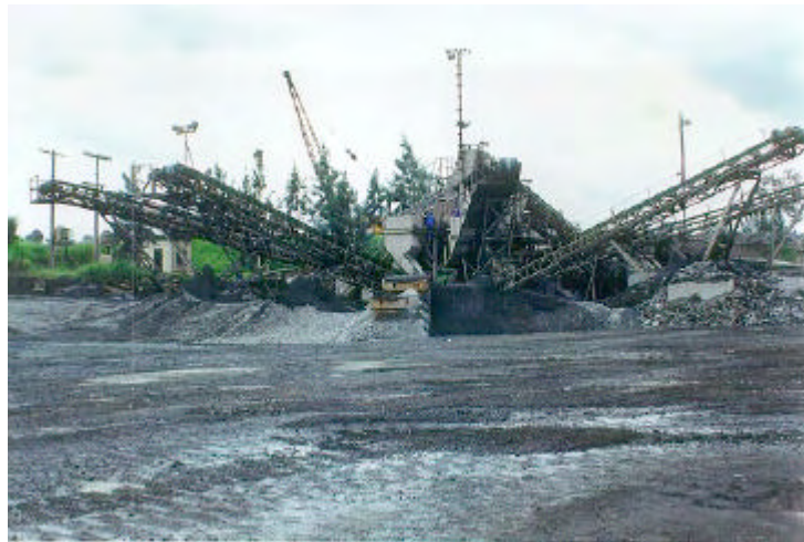
FIGURA 3 Planta de beneficiamento para separação magnética da escória de aciaria
