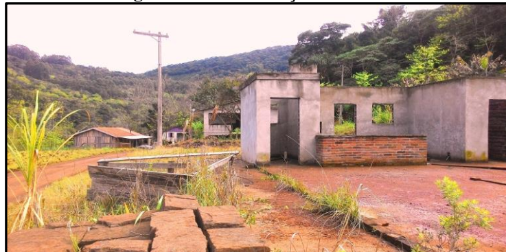
Figura 19 – A construção inacabada
