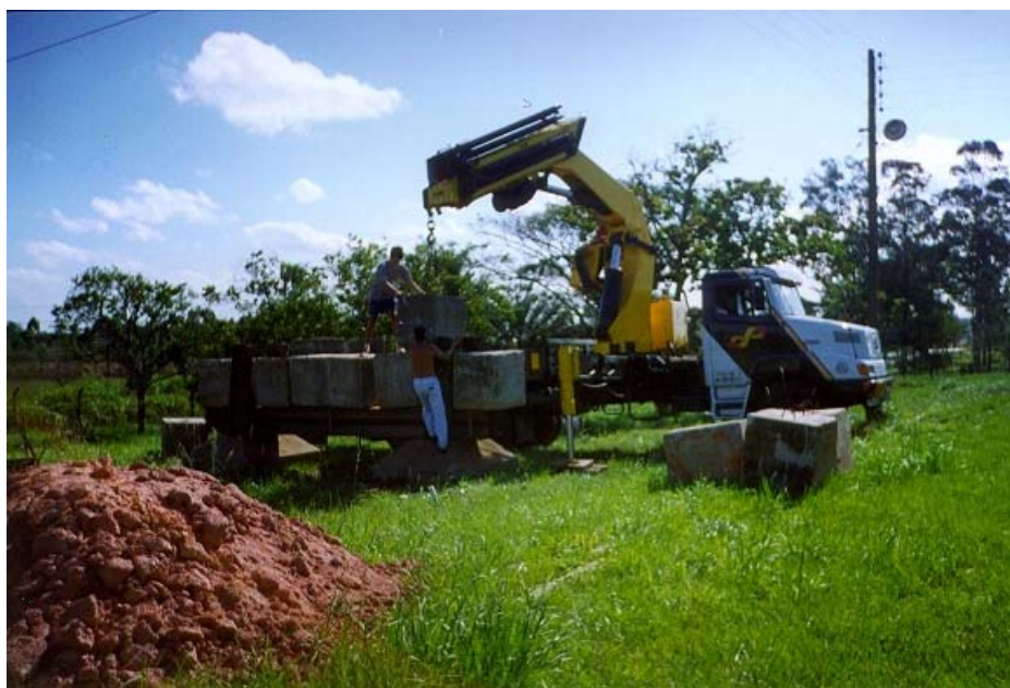
Figura 4.8 – Montagem do sistema de reação
