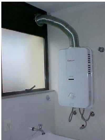
Figura 51 – Aquecedor a gás instalado com ventilação e exaustão permanentes.
