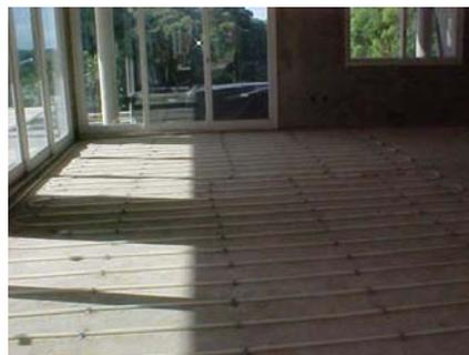
Figura 19 - Aquecimento elétrico de piso
