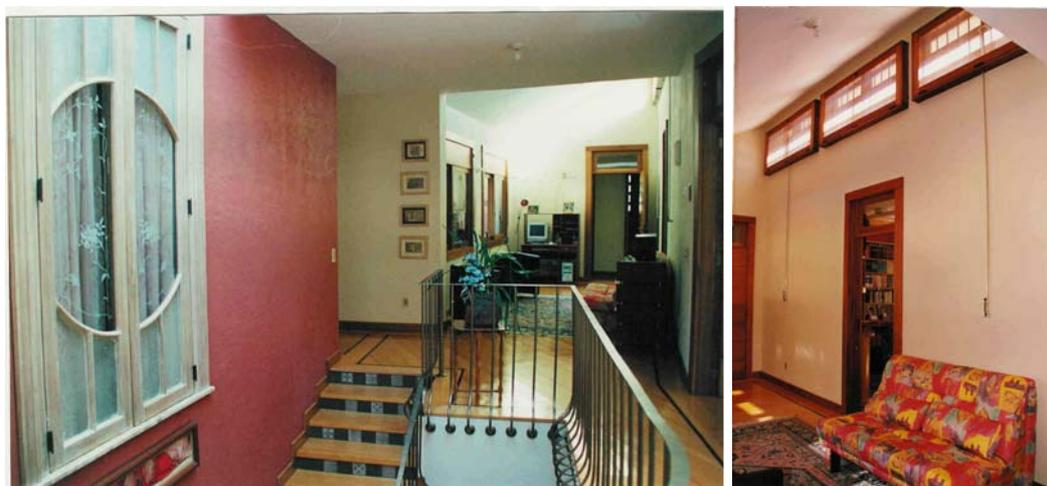
Figura 9 – Combinação de janelas permitindo ventilação cruzada.
