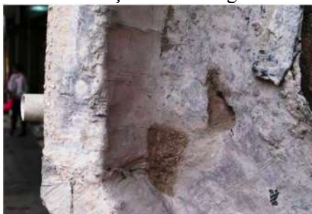
Figura 7 - Tubulações de drenagem obstruídas
