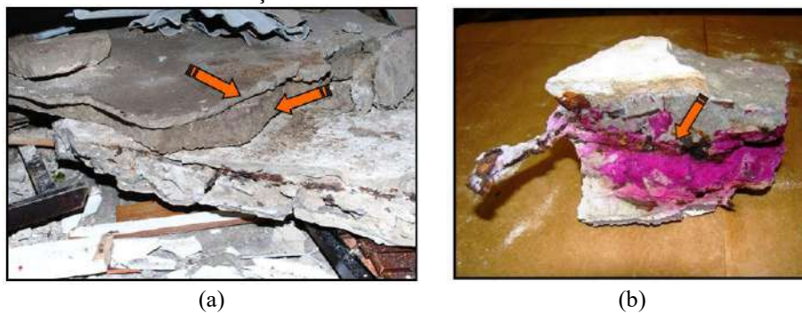
Figura 3 - (a) Camadas de revestimento no elemento inspecionado (indicadas pelas setas) e (b) análise da frente de carbonatação com indicador colorimétrico de fenolftaleína
