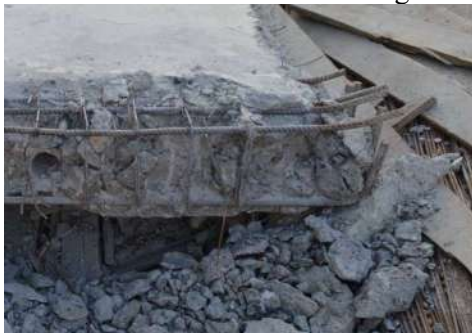
Figura 10 - Armadura na extremidade de ancoragem de uma das vigas
