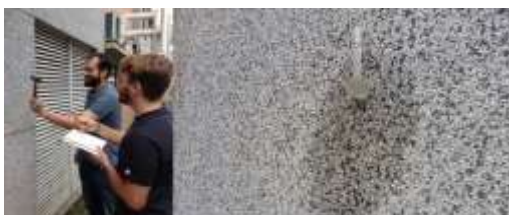
Figura 14: (a) Levantamento de percussão em fachada (b) Ensaio de absorção de água
