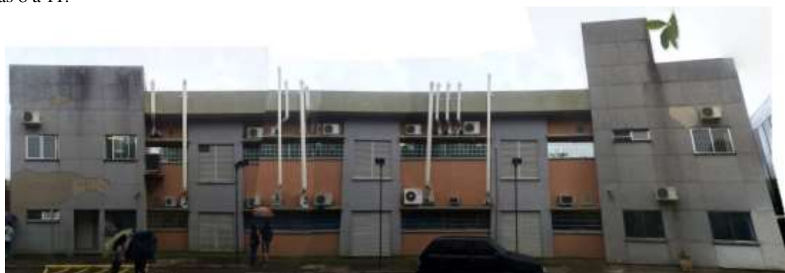
Figura 7: Foto panorâmica da fachada
