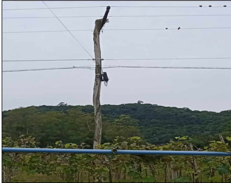
Figura 11- Poste com caixa de transmissão de fibra ótica para as famílias do interior
