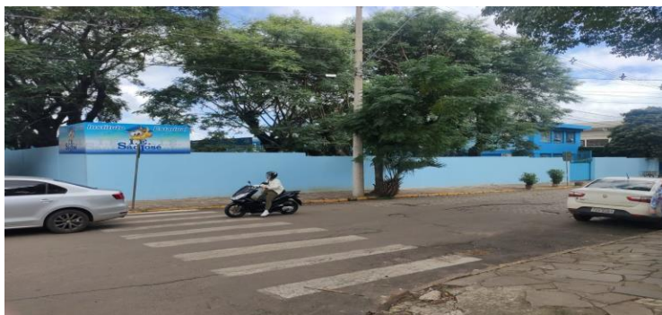
Figura 1- Fachada principal da escola.
