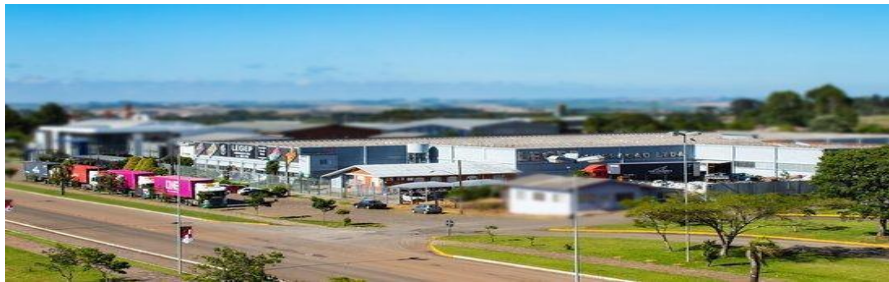
Figura 10- Vista aérea da estrutura industrial de mineração
