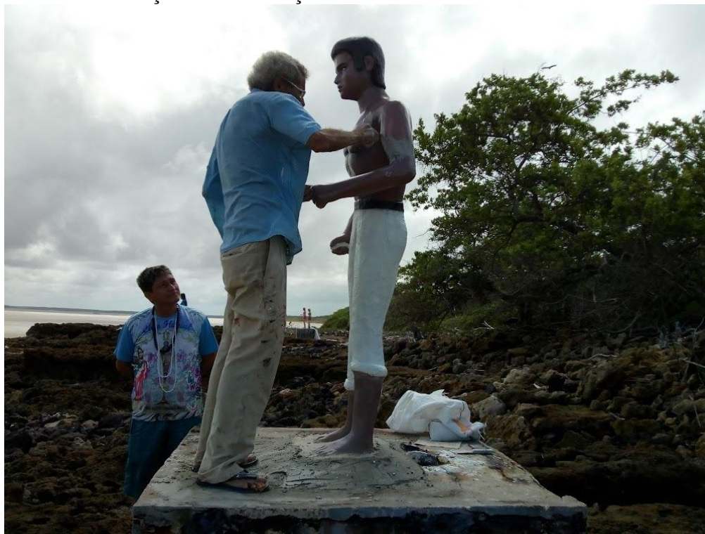
Ilustração 14 – Instalação do novo Zé Raimundo em 2019.
